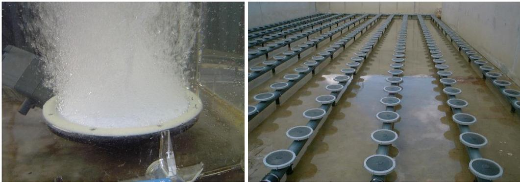
Figura 24. Difusor de burbuja fina (izquierda) y sistema de difusores (derecha) <sup>[19]</sup>.
