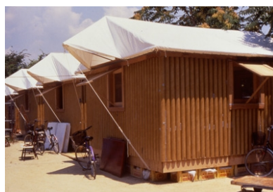
Ilustración 19. Refugio para el terremoto de Kobe (Japón). Fuente. http://www.shigerubanarchitects.com/works/1995_paper-log-house-kobe/index.html
