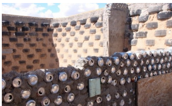
Ilustración 5. Construcción con neumáticos y latas. Fuente. http://noticias.arq.com.mx/Detalles/16798.html#.Vd4KQyXtmk
