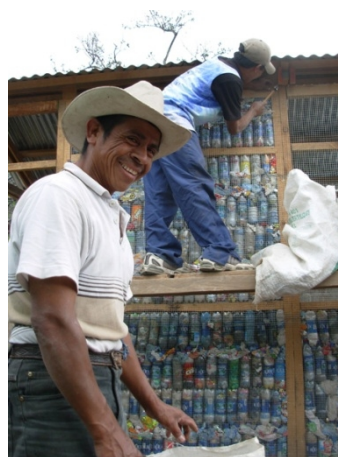
Ilustración 4. Construcción botellas PET. Asociación pura vida. Fuente. http://caliescribe.com/servicios-y-medioambiente/2012/03/31/2491-como-construir-casa-botellas-plastico
