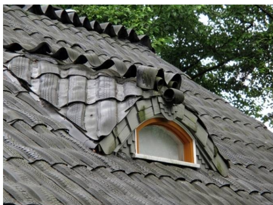
Ilustración 6. Construcción con neumáticos cortados. Fuente. http://gaiachile.es.tl/PROYECTOS.htm
