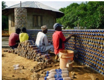
Ilustración 3. Construcción con botellas PET en Nigeria. Fuente. http://ecoinventos.com/casa-construida-con-botellas-pet-recicladas-en-nigeria
