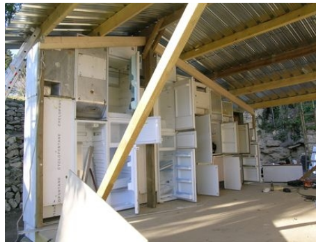
Ilustración 12. Pared realizada con frigoríficos. Fuente. http://www.microclimax.org/projets/salonfrigo.html
