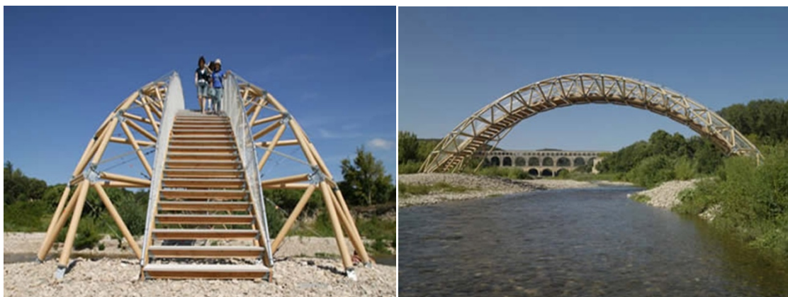
Ilustración 23. Puente de cartón, cerca de Nimes (Francia). Fuente. http://www.shigerubanarchitects.com/works/2007_paper-bridge/index.html
