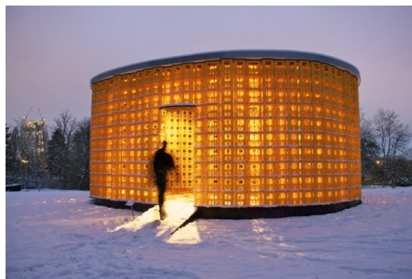
Ilustración 10. Construcción con cajas de transporte de bebidas. Fuente. http://winter-hoerbelt.de/selected-works/cratehouse
