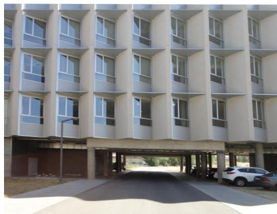
FIGURA 9. Fachada Sur-Oeste del edificio LUCIA. Imagen propia.
