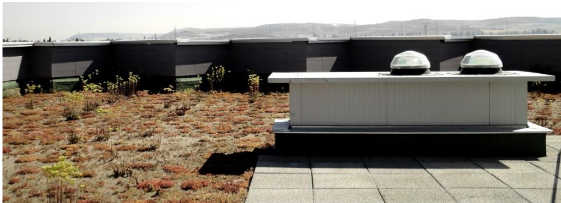
FIGURA 60. Imagen de la cubierta ajardinada extensiva con los captadores solares. Imagen propia tomada el 21 de julio a las 11: 35.
