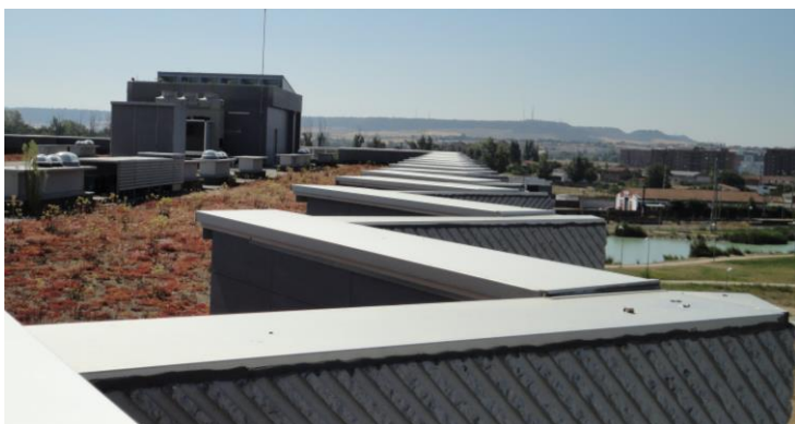
FIGURA 56. Remate superior de los paneles prefabricados de hormigón. Imagen propia, 21 de julio a las 11:30h.
