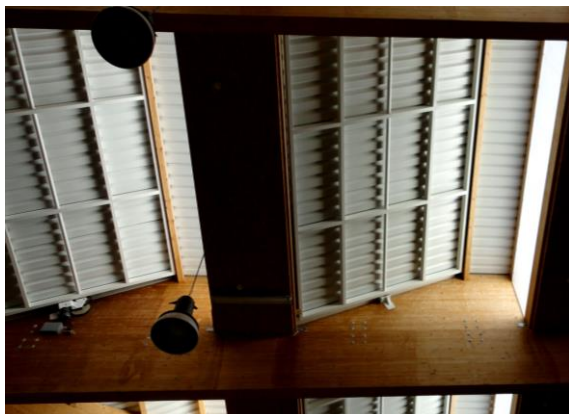
FIGURA 42. Paneles móviles de cubierta y estructura de madera laminada. Imagen propia.
