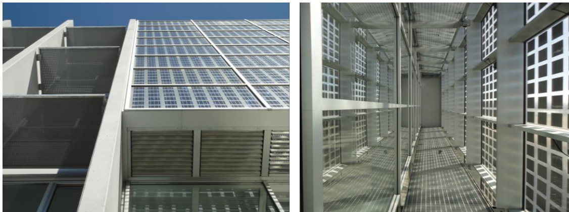
FIGURA 64. Doble piel fotovoltaica. Izquierda, exterior con rejilla de ventilación inferior; derecha, interior de la doble piel. Imágenes propias tomadas el 21 de julio a las 12:15 y 11:45 horas respectivamente.
