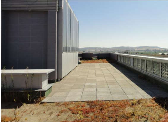
FIGURA 67. Izquierda, lucernario fotovoltaico Sur; derecha, ventilación superior de la doble piel fotovoltaica.
