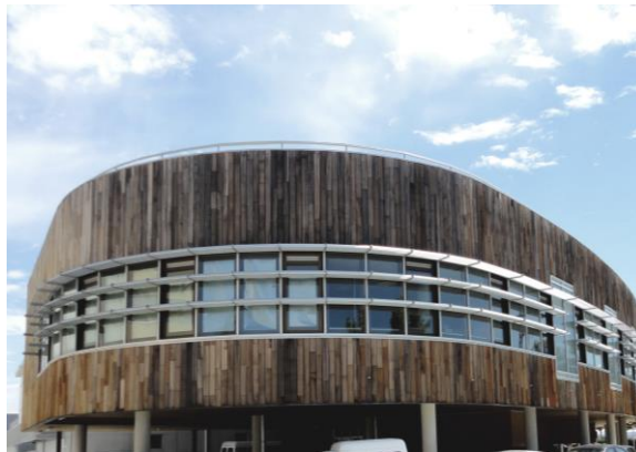
FIGURA 7. Frente de fachada Oeste edificio ENVITE. Imagen propia.
