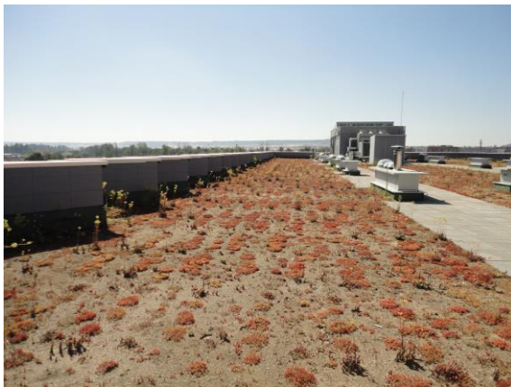
FIGURA 46. Cubierta extensiva, vista hacia el sur. Imagen propia tomada el 9 de julio a las 11:00 h.
