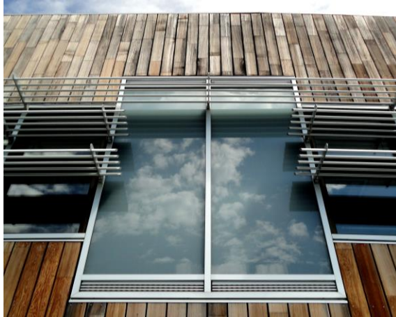
FIGURA 31. Captador solar del edificio ENVITE. Imagen propia tomada a las 13:15 horas, julio. Derecha, sistema con muro Trombe, imagen propia.
