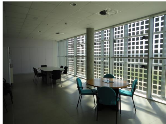
FIGURA 47. Imagen del espacio de spin-off y la doble piel fotovoltaica. Imagen propia tomada el 9 de julio a las 10:40 h.
