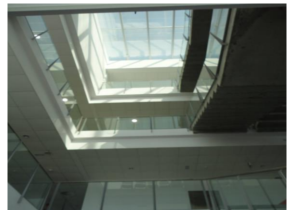
FIGURA 49. Lucernario Sur, vista interior desde la planta baja. Imagen propia.
