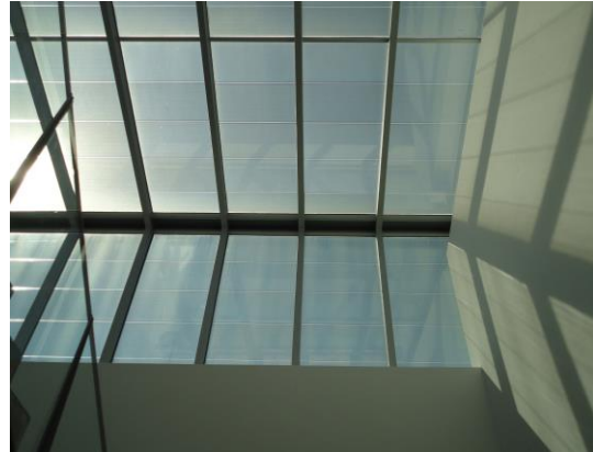
FIGURA 68. Lucernario fotovoltaico Sur desde el espacio interior. Imagen propia, 11:30 h.
