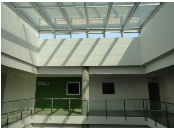
FIGURA 48. Lucernario norte, vista interior desde la tercera planta.
