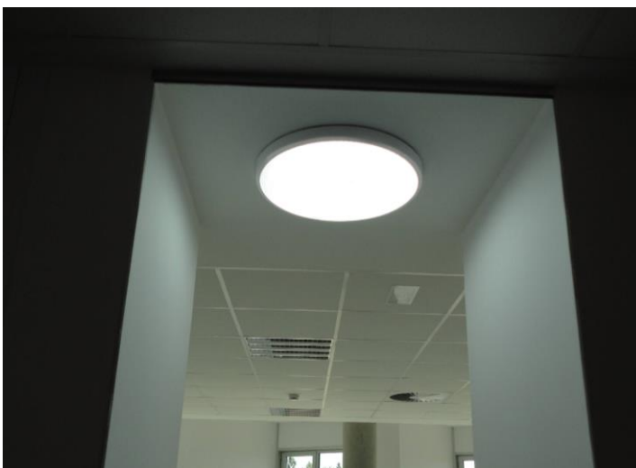
FIGURA 63. Solatube tipo horizontal. Imagen propia.
