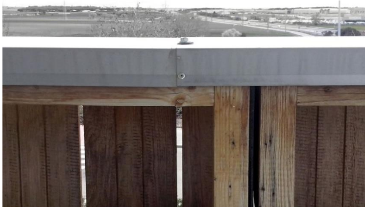
FIGURA 22. Subestructura de madera vista debido a mantenimiento, situado en el espacio perimetral al auditorio en cubierta. Imagen propia tomada durante la visita al edificio.
