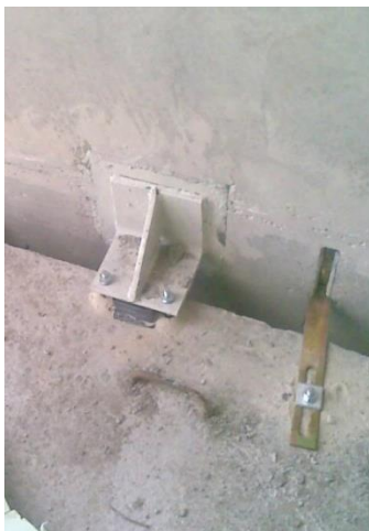
FIGURA 53. Anclajes mediante angular y anclaje de retención. Fuente: documentación gráfica del proyecto y fotos de obra proporcionadas por la Unidad Técnica de la UVa
