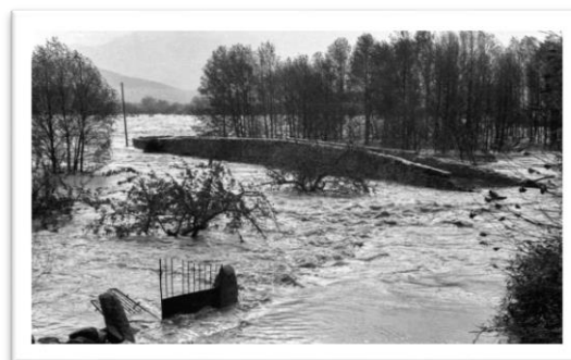
Imagen 1 Puente de las Aceñas
