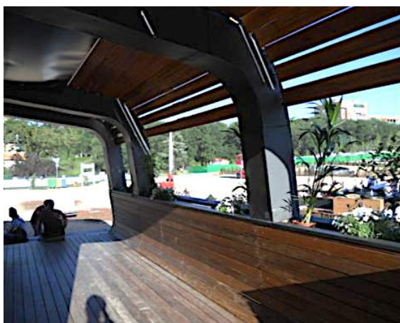
Figura 1.5. Espacio abierto filtrado por lamas fotovoltaicas.
