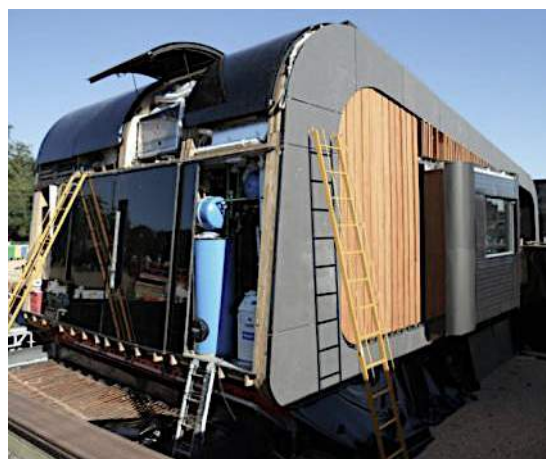
Figura 1.6. Mochilas técnicas (zona norte) durante la construcción.
