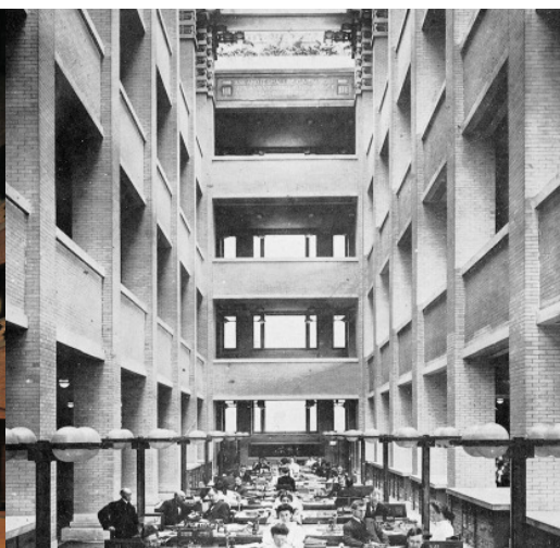
i.12. Edificio Larkin, Buffalo, Frank LL. Wright. 1903-1905.
