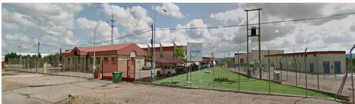
Centro de Transporte de Enagás en Cigales, Valladolid
