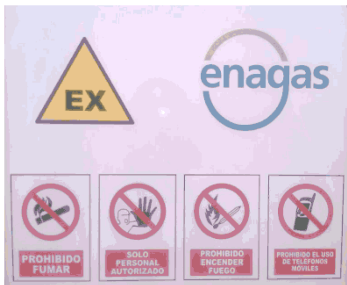
Señalización de instalaciones con riesgo de atmósferas explosivas
