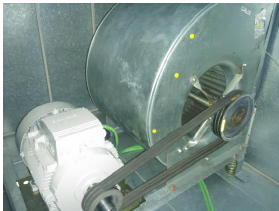
Figura 4. Conjunto motor-ventilador
