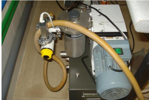
Figura 2.9. Bomba de vacío, trampa fría y medidor de vacío Pirani
