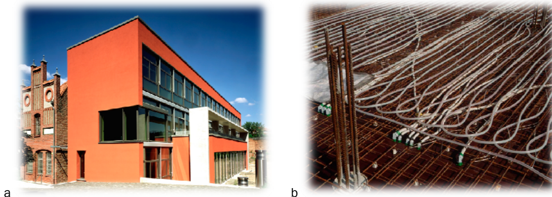
Figura VI.1. Vista general del edificio ZUB en Kassel, con especial atención a la fachada Sur (a), y disposición de los tubos embebidos en la estructura del edificio durante la fase de obra (b). Fuente: [Hauser et al. 2004]
