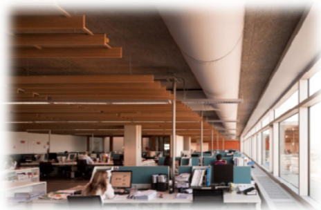
Figura V.2.- Vista interior de un espacio diáfano de oficina en el que se aprecian los sistemas TABS, el sistema de ventilación mediante conductos textiles y la fachada acristalada en orientación Norte. Fuente: [Villanueva 2013]
