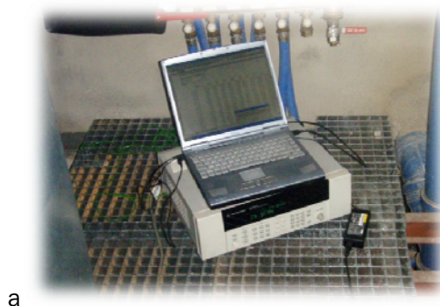
Figura V.7. Vista del adquirente dispuesto para su conexión in-situ con las sondas embebidas en el forjado.
