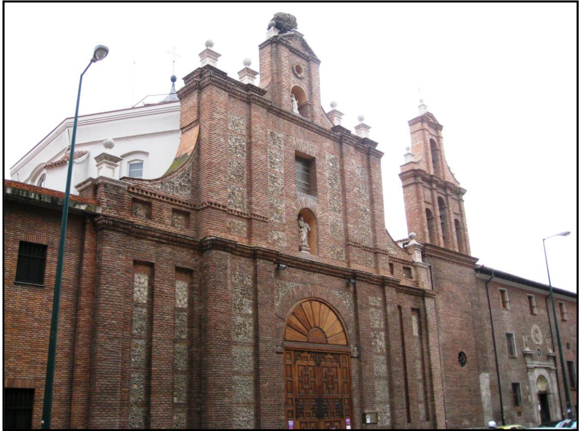
Fig. 5- Pedro Bibanco. Real Colegio de los Ingleses . Valladolid.
