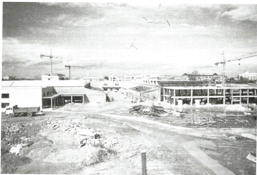
Foto 3.- Aulario y Enología en construcción. Foto: E. Delgado. Marzo de 2001.
