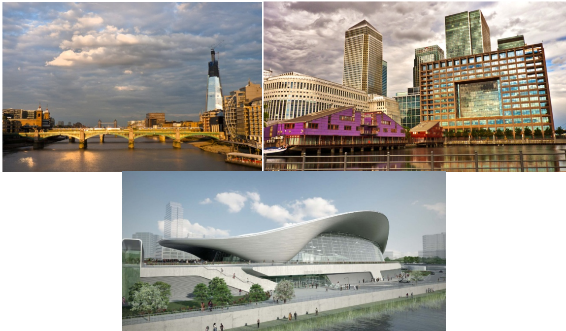
The Shard. Canary Wharf. Centro Acuático de Zaha Hadid. Fuente: El Arquitecto Viajero
