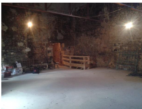
Figura 2: Estado actual de la planta de extracción II.
