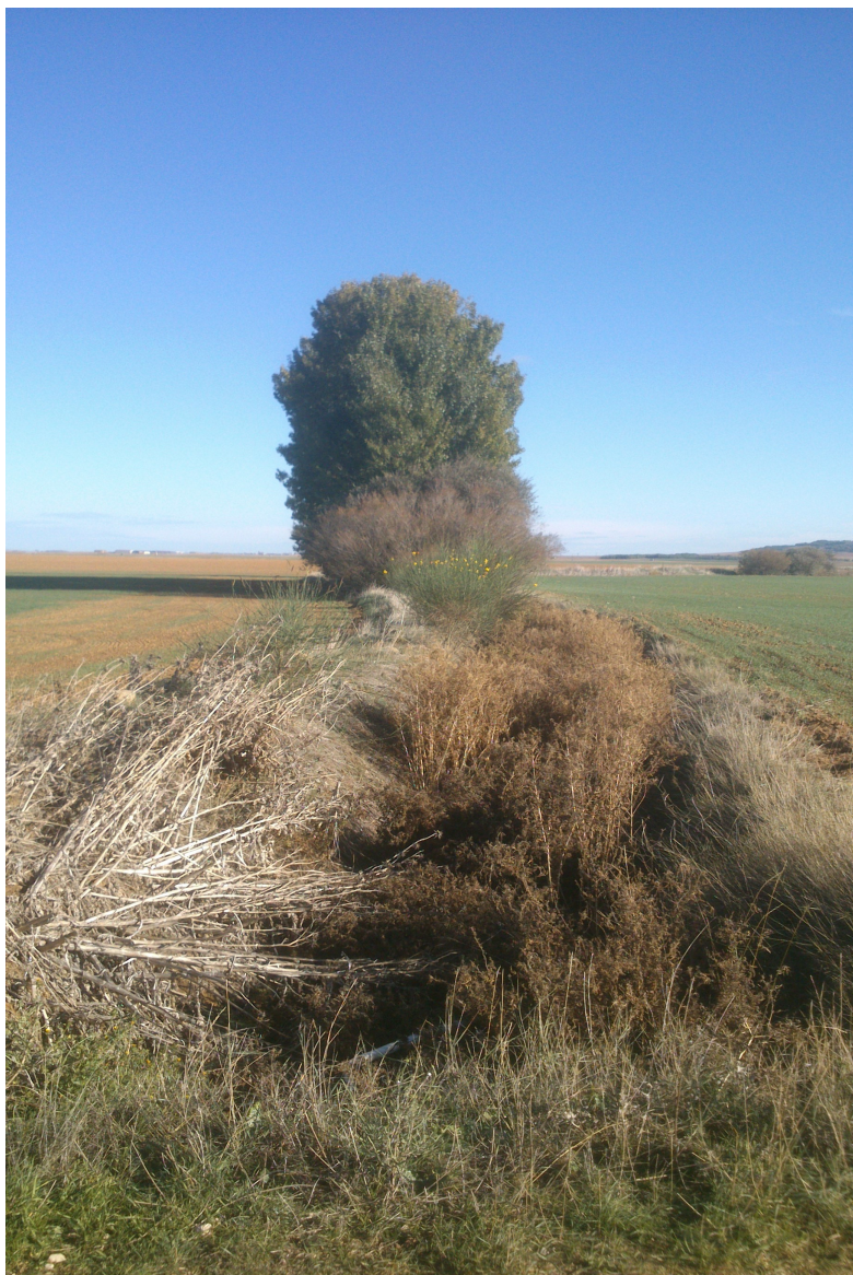
Foto 12. Arroyo Marrandiel a su paso por el Polígono 507 del municipio de Villagarcía de Campos. Se observa la presencia de algunos pies aislados en la ribera del arroyo.
