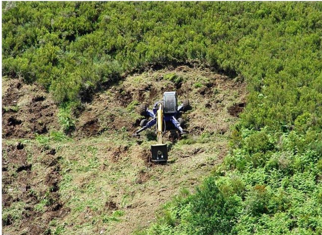
Figura 1. Retroaraña con cabezal desbrozador – ahoyador. (Fuente: Medioambiental Valledor S.L.)
