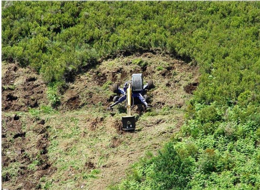
Figura 7. Retroaraña con cabezal desbrozador – ahoyador. (Fuente: Medioambiental Valledor S.L.)
