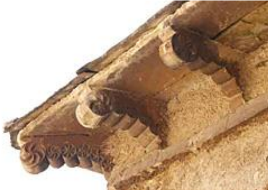
Figura 20. Modillones de rollos de los aleros de Santiago de Peñalba, León.
