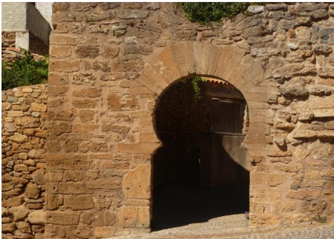
Figura 46. Puerta del Barrio Moro, Agreda
