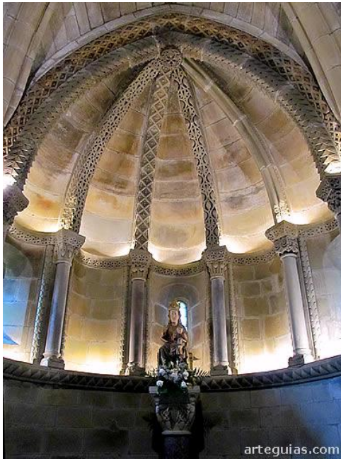
Figura 59. Bóveda gallonada del ábside de Arbas del Puerto, León
