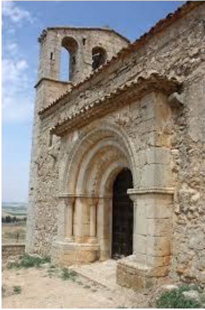
Figura 65. Fachada de la iglesia de Perdices, Soria
