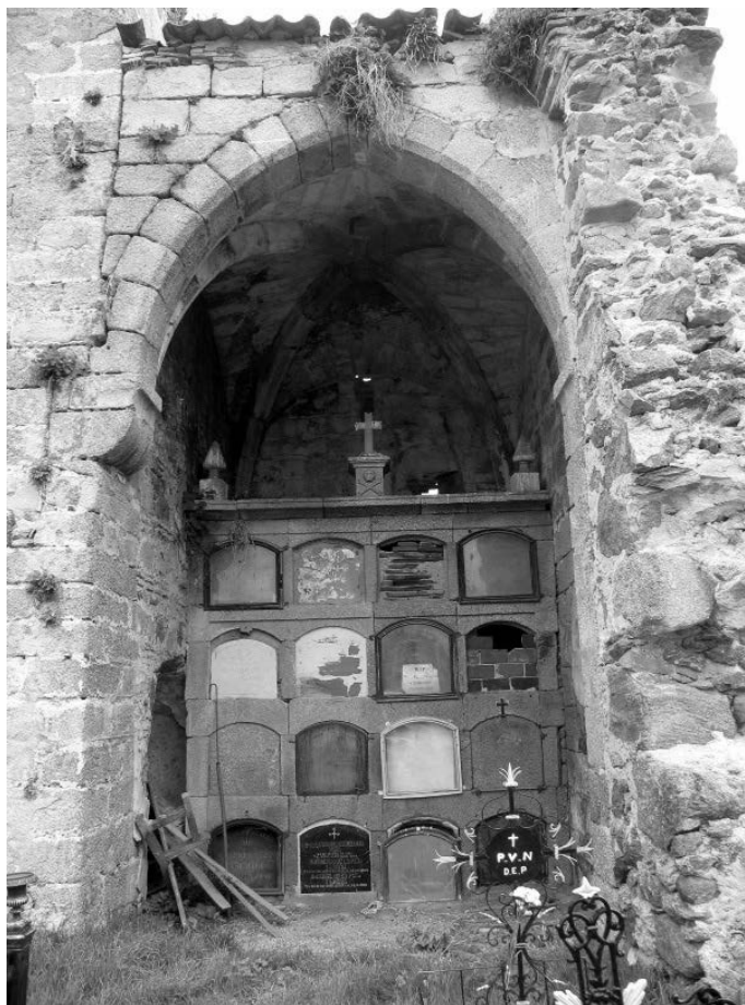
Fig. 4. Interior de la iglesia. Capilla meridional.
