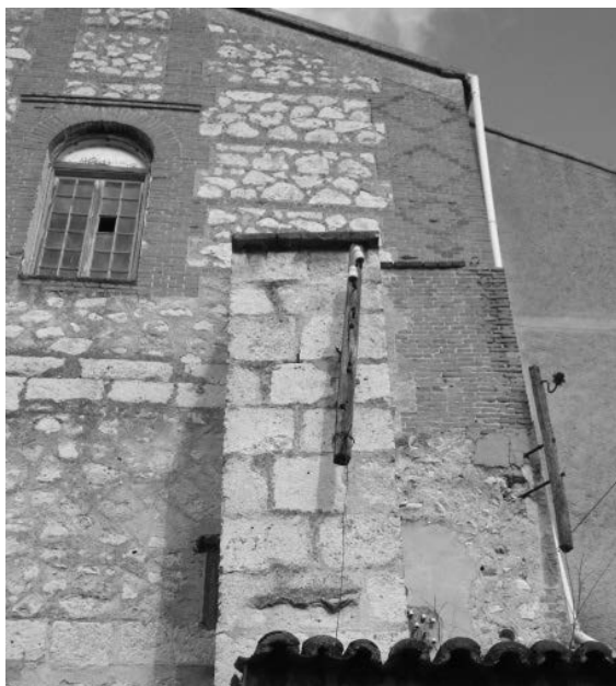
Fig. 5. Estribo noroccidental de la antigua iglesia de San Pedro, situado en el hastial oeste. Bartolomé de Cubillas y Hernando del Río. 1564. Íscar (Valladolid).
