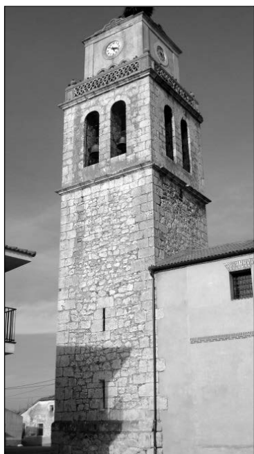
Fig. 3. Torre de la Iglesia de San Sebastián. Villaverde de Íscar (Segovia).
