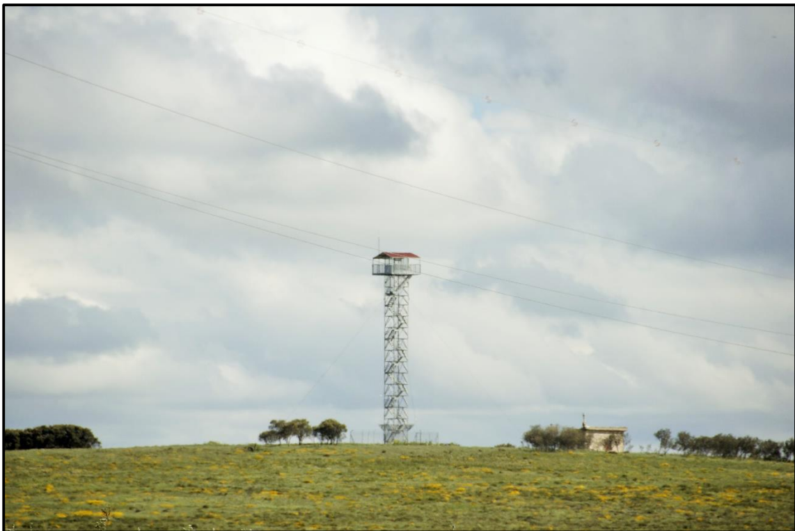
Fotografía 6. Torreta “Páramo de Masa” de vigilancia contra incendios encargada del avistamiento de columnas de humo en todo el área de estudio.
