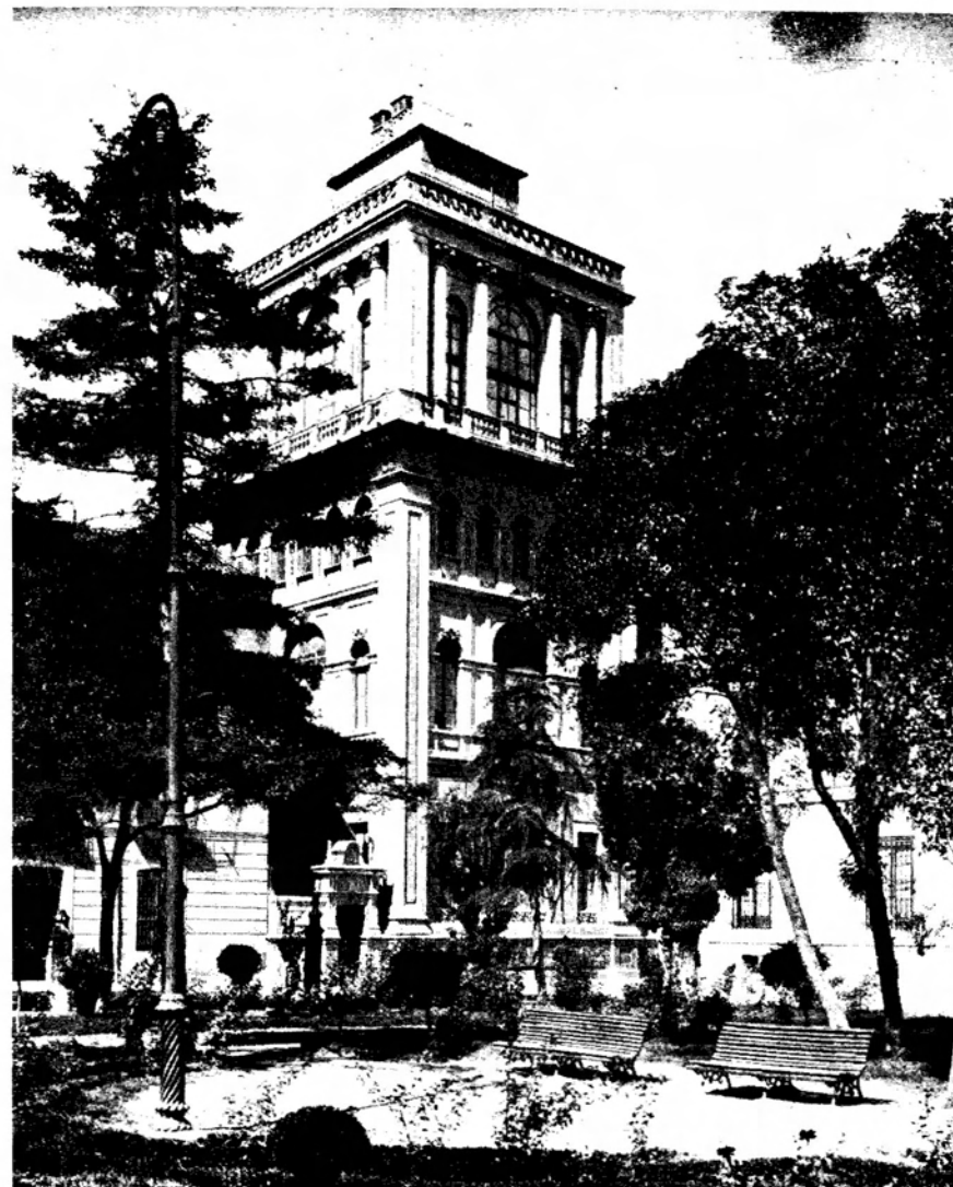
LÁMINA I.—Torre de la Universidad. En el plano superior, están instalados el anemómetro, veletas, pluviómetros, barógrafos, heliógrafo, termómetros seco y húmedo, higrómetro. Debajo primera balconada, desde la cual por el interior está la escalera. Cuerpo adornado por columnas, instalación de los aparatos registradores. Debajo pequeño cuerpo, con habitaciones para los trabajos de cálculo y estadística. Despacho y biblioteca y en el interior aparato de Radio, ojo foto-eléctrico, pequeño cinematógrafo, microscopio de proyección. En la parte inferior. Sala de Física donde está el grupo de transformación eléctrica y taller de Física. Entrada al pequeño patio ante el paraninfo que comunica con los laboratorios de Química.
