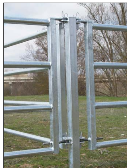
M1 DETALLE DE BARRERA PARA SEPARACIÓN DE PARQUES DE OVINO DE HIERRO GALVANIZADO (DIMENSIONES EN FUNCIÓN DE TAMAÑO DE GANADO)
