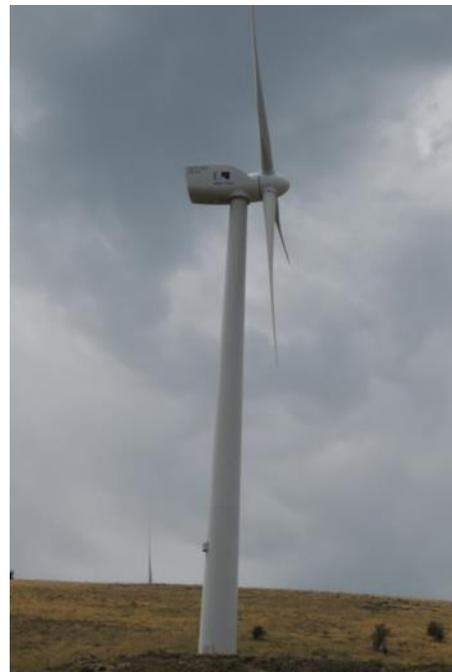
Figura 2.13. Torre tronco-cónica de acero del parque eólico El Cayo.
