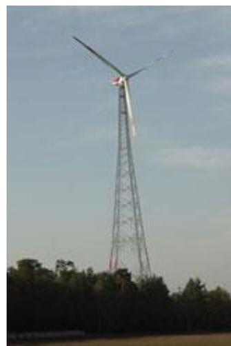
Figura 2.12. Aerogenerador con torre en celosía. [6]
