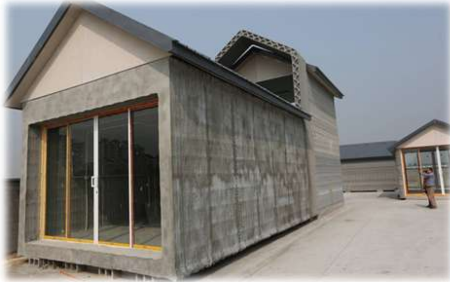
Figura 3.34. Casa obtenida mediante una impresora 3D de grandes dimensiones
