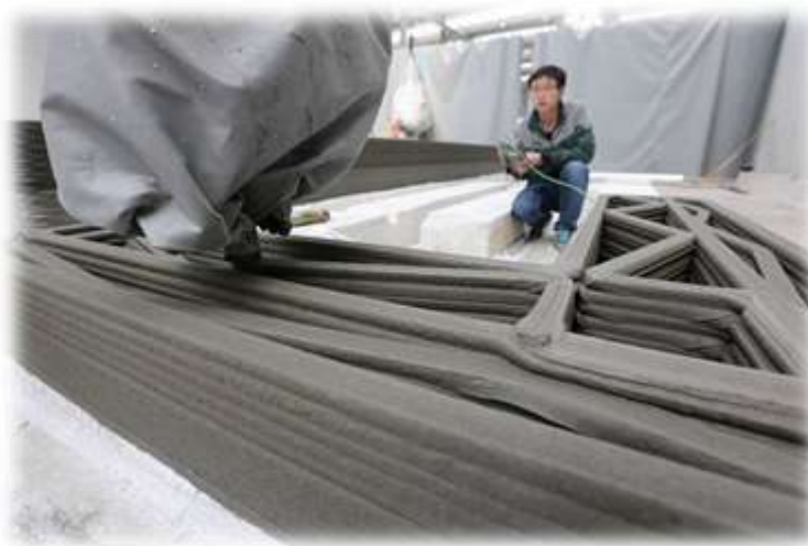
Figura 3.33 Método de extrusión para impresión de casas
