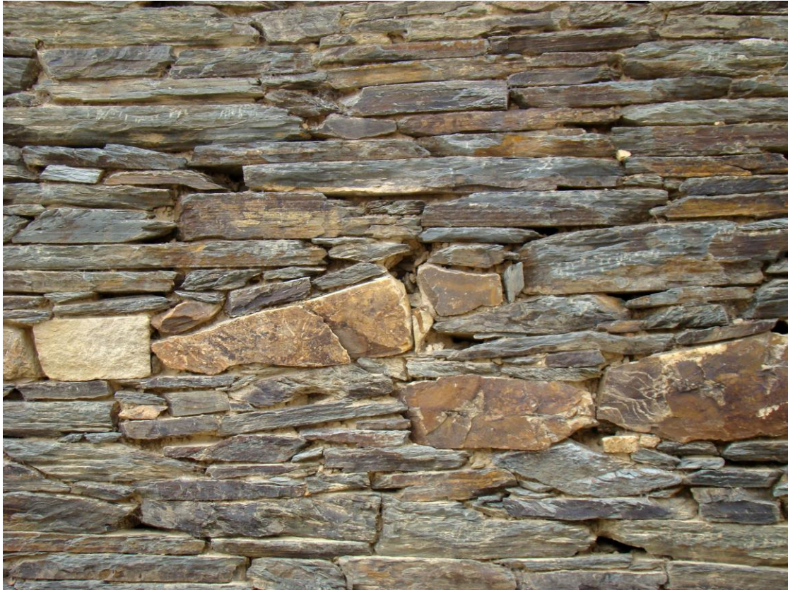
Santiago Millas. Muro de mampostería con cuarcitas. Foto: E. Delgado. 2012
