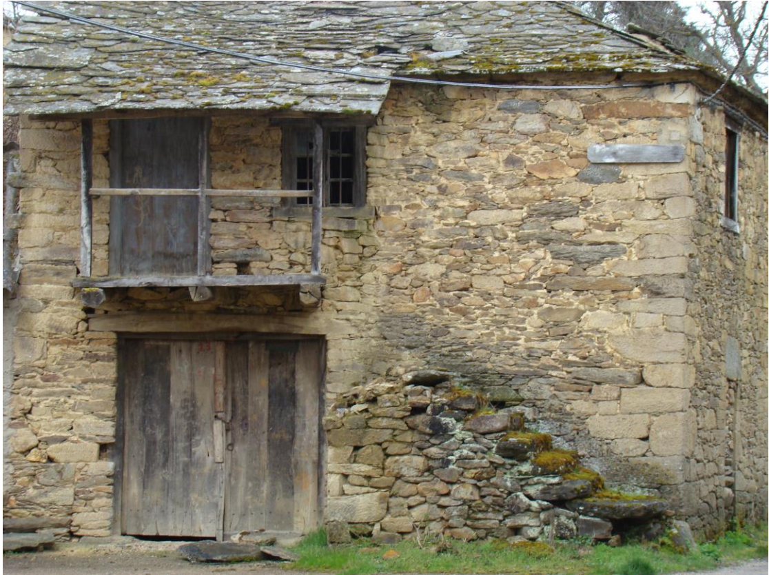
Truchas. Escalera exterior. Foto: Enrique Delgado. 2012
