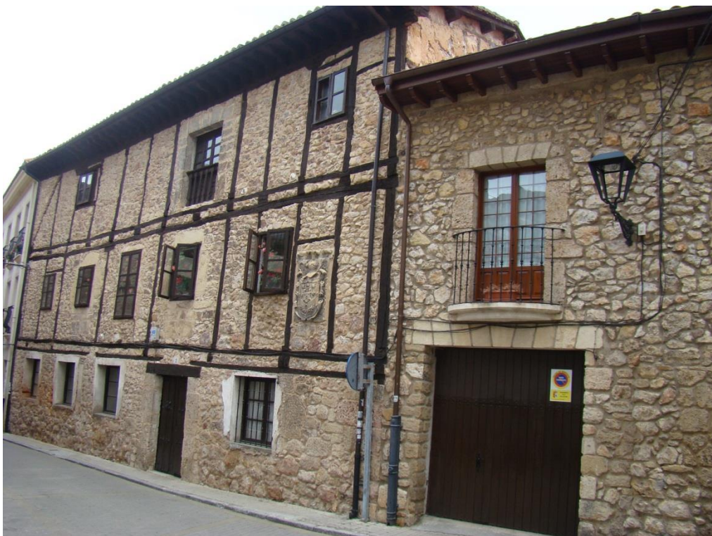
Oña. Calle del Pan. Entramado de nueva construcción con piedra. E. Delgado
