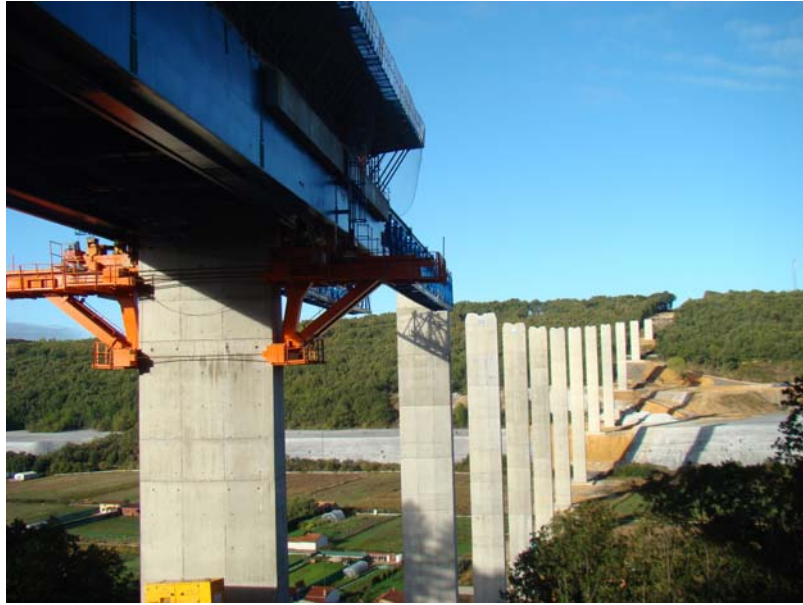
Guardo. Viaducto para la circunvalación. Foto: E. delgado. 2012
