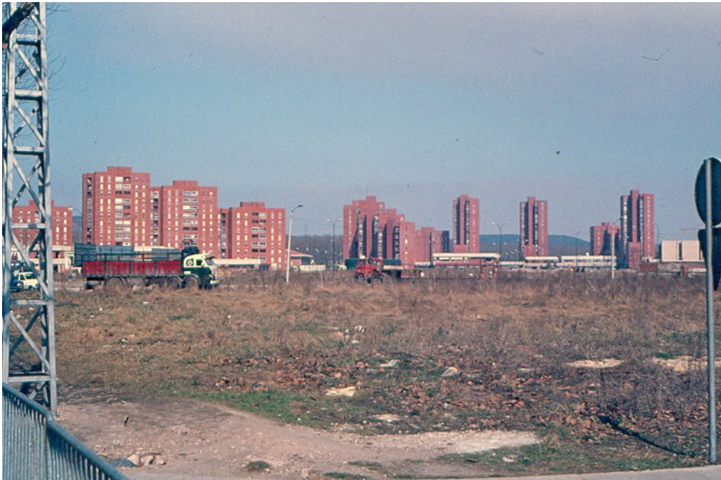
Aspecto del Polígono Residencial en 1984. Foto: E. Delgado
