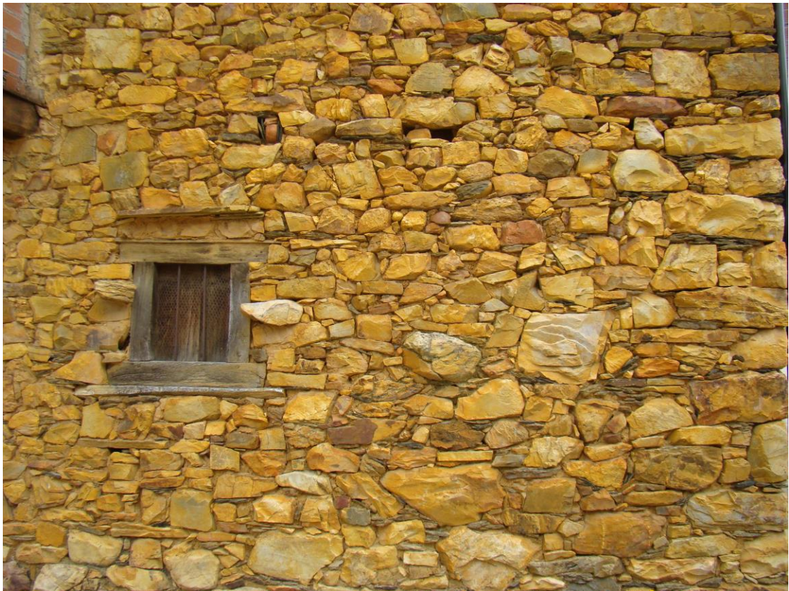
Castrocontrigo-Morla de la Valdería. Muro de mampostería. Foto: E. Delgado. 2012
