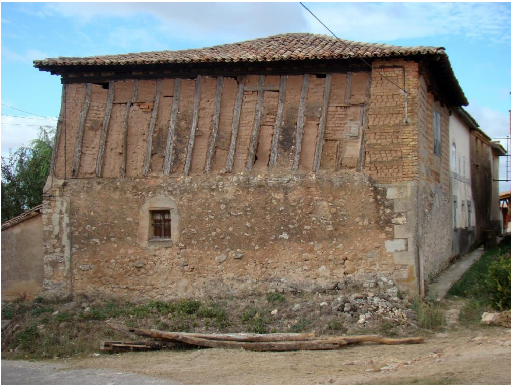
Bustos de Bureba. Entramado de pies derechos y adobe sobre zócalo de mampostería. E. Delgado
