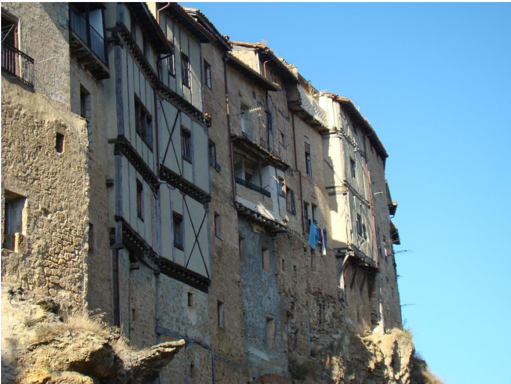
Frías. Casas colgadas. Forjados y entramados de madera. E. Delgado
