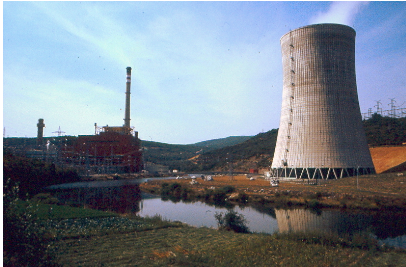
Velilla del Río Carrión. Central Térmica. Foto: E. Delgado 1987
