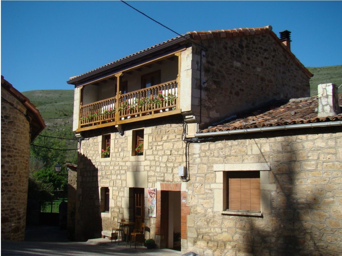
Casa con solana montañesa y cortafuegos. Sedano (Valle de Sedano). Foto: Enrique Delgado
