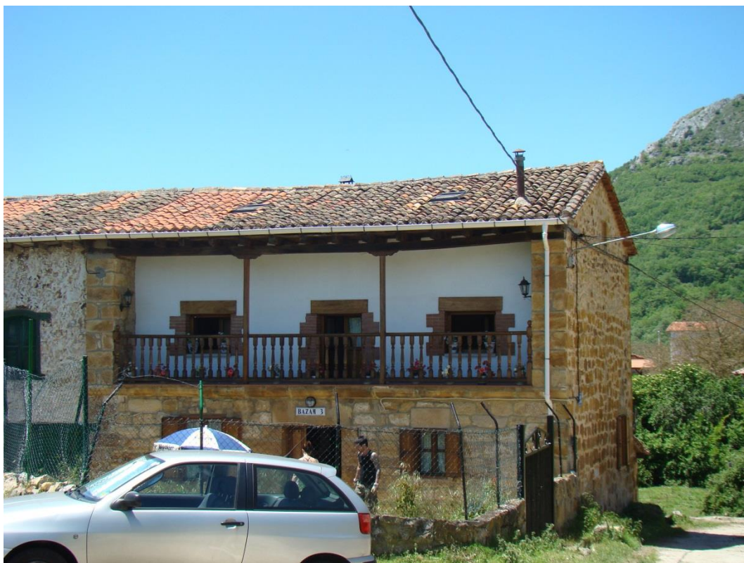
Valle de Valdebezana-Munilla. Balcón encastrado con cortavientos. E. Delgado
