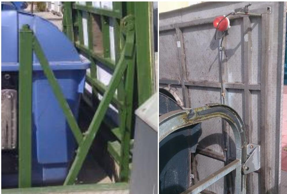
Figura 2.6. Ejemplos de guías de elevación simultánea de plataforma y chapas superficiales. (Fuente: IT 06, Ayto. Vélez)(2014).
