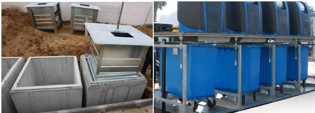
Figura 2.4. Distinción entre espacios para el soterrado de contenedores. (Fuente: Contenur).
