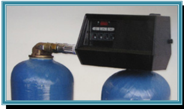
Figura 6.4 Cabezal controlador de los dos botellones.
