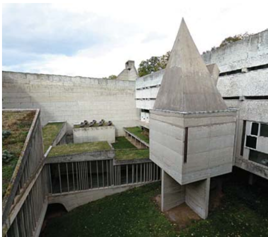
185 Claustro de La Tourette Éveux Le Corbusier 1957
