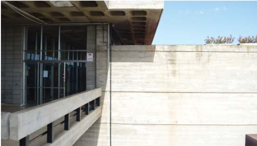
863 Muro de hormigón visto del colegio La Pureza de María Los Realejos Fray Coello de Portugal 1972
