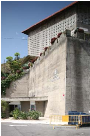
869 Muro de contención y vivienda del guarda en el colegio La Pureza de María Los Realejos Fray Coello de Portugal 1972
