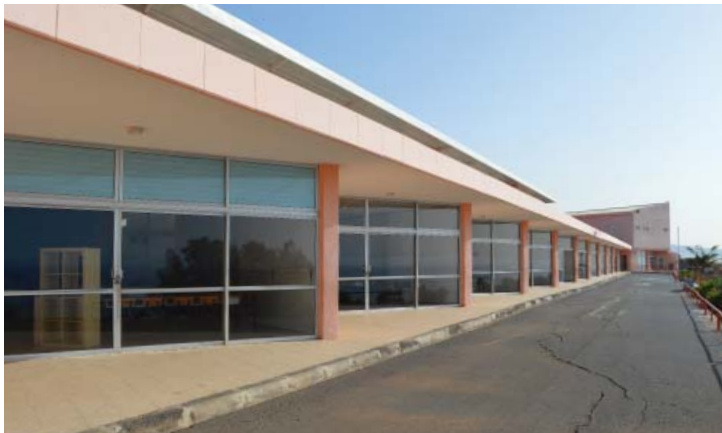
873 Corredor exterior de aulas del colegio Adonai Tenerife Fray Coello de Portugal 1980
