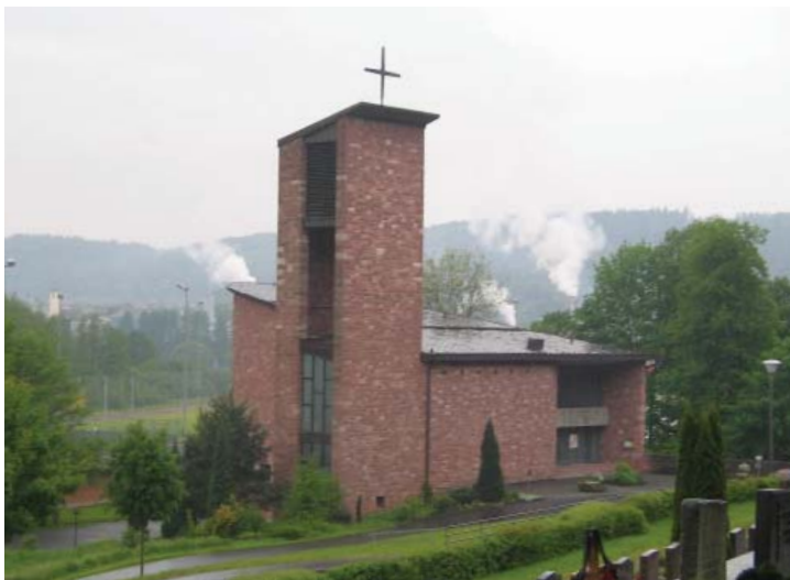
474 Iglesia de San José Hasloch-am-Main Hans Schädel 1958
