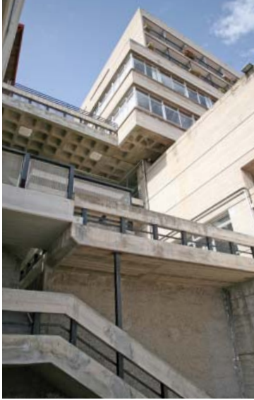
862 Escaleras exteriores de comunicación vertical del colegio La Pureza de María Los Realejos Fray Coello de Portugal 1972
