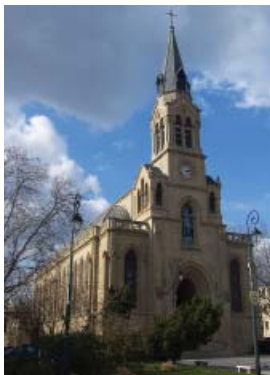
34 Iglesia de St Marguerite du Le Vesinet Louis Auguste Boileau 1855
