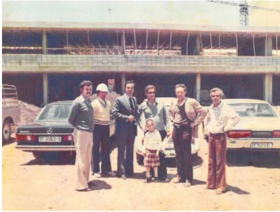
777 Colegio Hispánico Británico en construcción Tenerife Fray Coello de Portugal 1976
