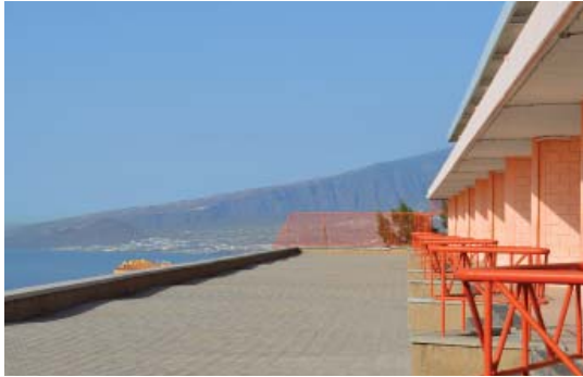
880 Corredor exterior de aulas del colegio Adonai Tenerife Fray Coello de Portugal 1980
