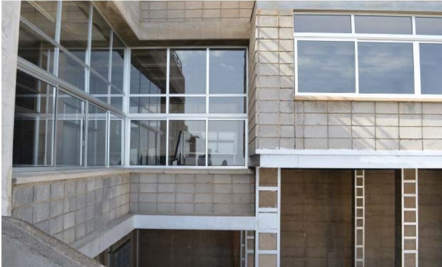
865 Fachada de bloque de hormigón en el colegio La Pureza de María Los Realejos Fray Coello de Portugal 1972
