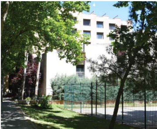
660 Centro parroquial de San Gabriel de la Dolorosa Madrid Fray Coello de Portugal 1990
