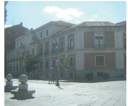
Edificio actual. Vista por la calle de las Angustias, desde la plaza de San Pablo.
