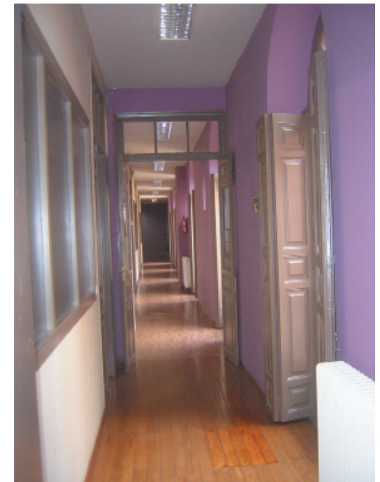
Pasillo interior de las Escuelas Públicas de Palencia en la planta alta, reformado para las necesidades actuales. Los techos se presentan con menor altura que la original para ubicar las distintas instalaciones.
