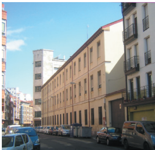
Vista de la manzana de actuación desde la calle del Empecinado.
