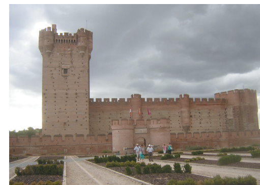
Castillo de la Mota en la actualidad: fachada principal de acceso noroccidental.
