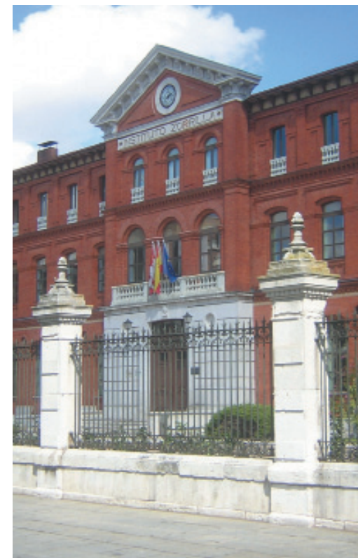
Paño central de la fachada principal.
