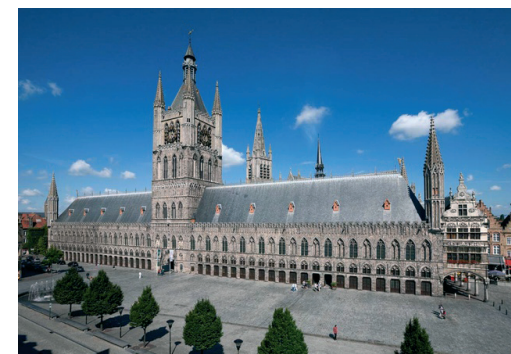
Lonja de Paños de Yprés (Bélgica). Ejemplo de edificio civil antiguo en estilo gótico.
