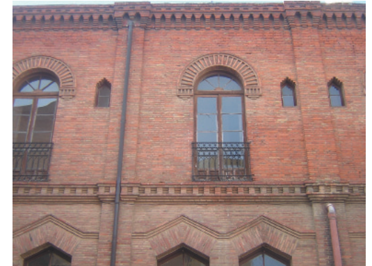
Huecos superiores del patio interior hacia el lado de la calle Valverde.
