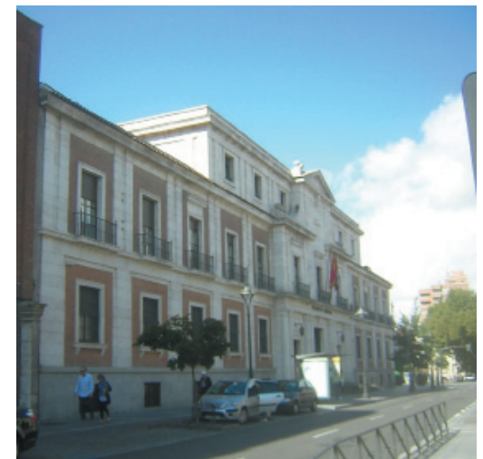
Edificio actual. Vista desde la calle de las Angustias.
