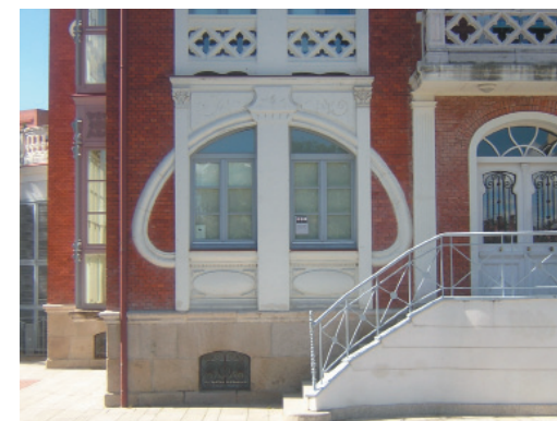
Casa Luelmo: hueco de ventana del salón.
