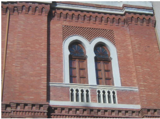
Huecos superiores de la fachada principal.
