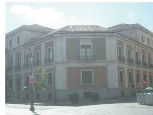
Edificio actual. Esquina entre las calles Platerías y Angustias.
