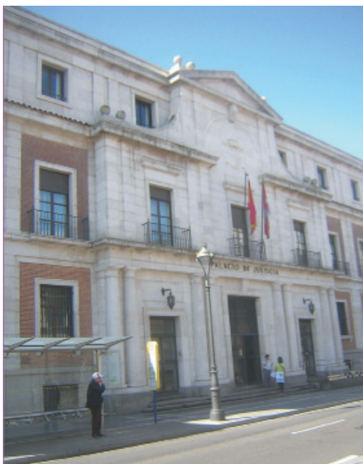
Edificio actual. Paño de la fachada principal.
