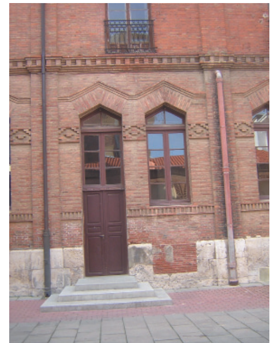
Huecos inferiores del patio interior hacia el lado de la calle Valverde.
