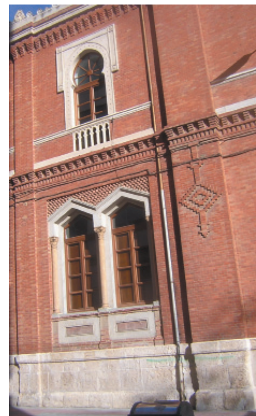
Paño de la fachada a la calle Valverde.
