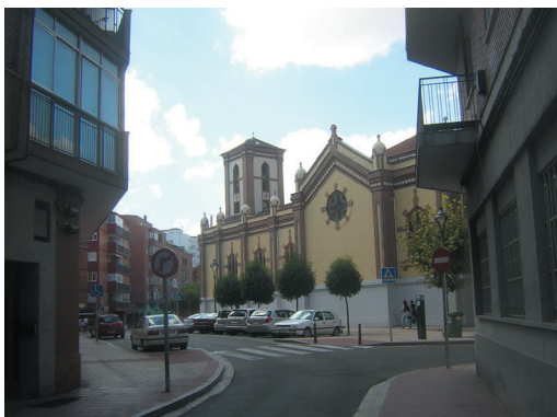
Vista de la antigua plazuela de San Bartolomé, hoy plaza de San Juan, con la actual iglesia parroquial del mismo nombre en su centro.
