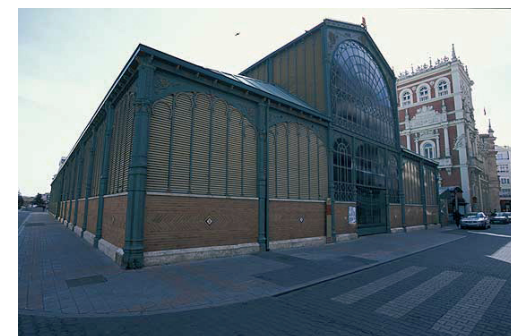
Plaza del mercado de Palencia. Vista desde la esquina del edificio proyectado por Juan Agapito y Revilla.
