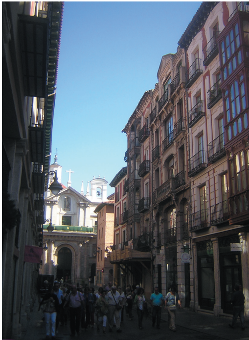
Vista actual de la calle Platerías de Valladolid, y de su edificio correspondiente al mismo que figura en los planos de este expediente.
