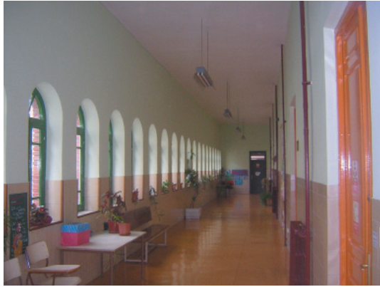
Interior de la galería en planta primera.
