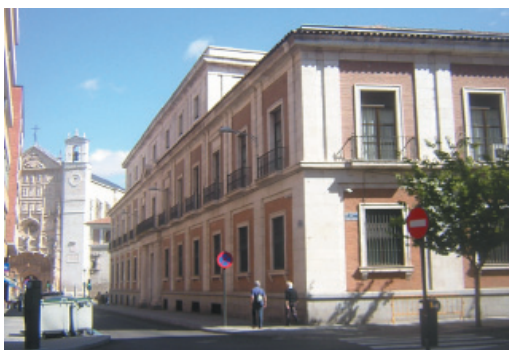
Edificio actual. Vista por la calle de Platerías.
