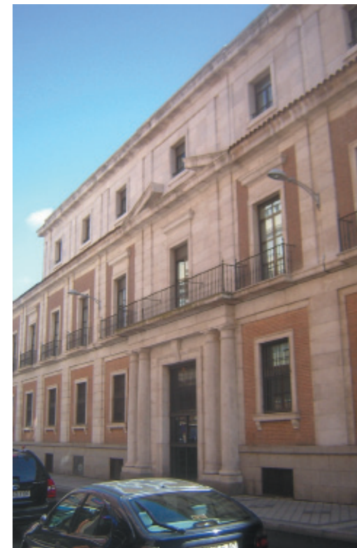
Edificio actual. Paño de la fachada a la calle de Platerías.
