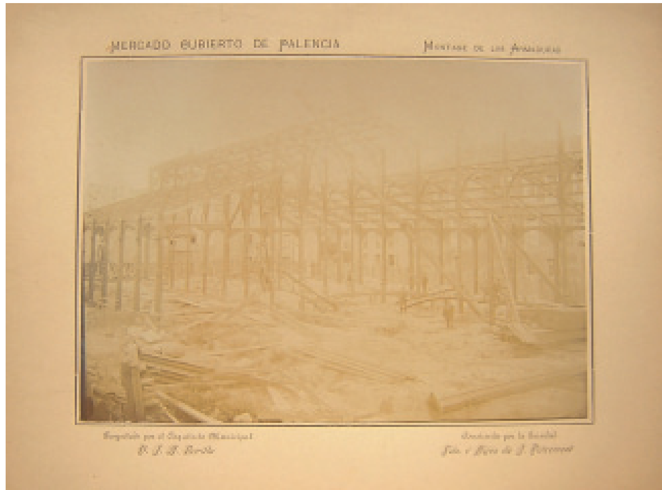
JAR-V 0030. Montaje de armaduras del Mercado de Palencia.
