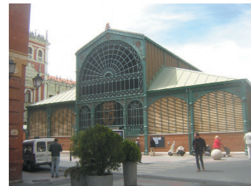
Mercado de Palencia. Fachada por la la calle Berruete.
