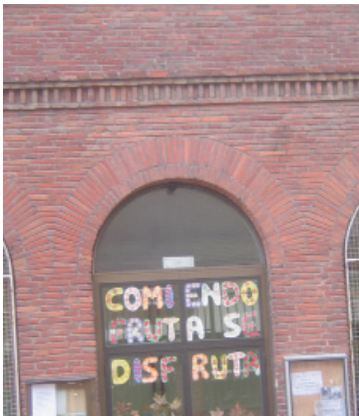
Fachada trasera. Arco del hueco de salida al patio trasero.
