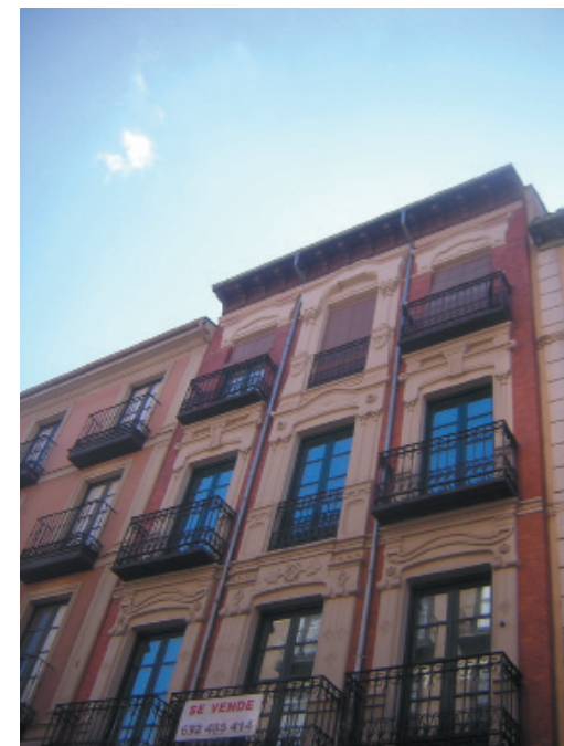
Actual edificación por la calle Lencería que coincide con el alzado a tinta en papel vegetal.
