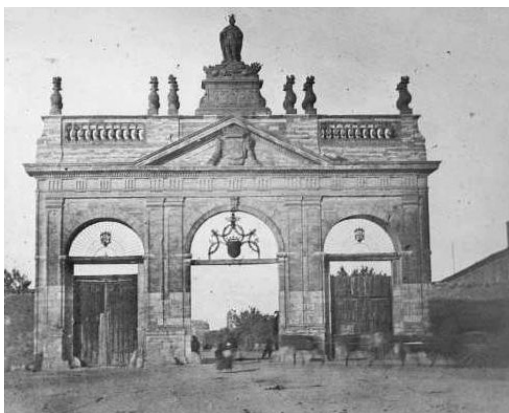
Antigua Puerta del Carmen de Valladolid, demolida junto con la de Santiago liberando espacio para las nuevas necesidades urbanas.
