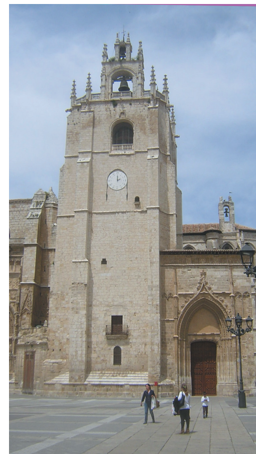
Vista de la torre de la catedral de Palencia.
