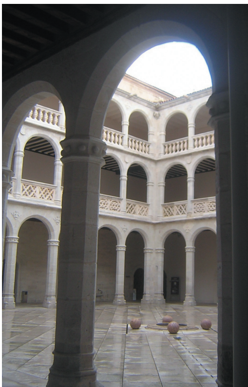
Palacio de Santa Cruz. Patio interior.
