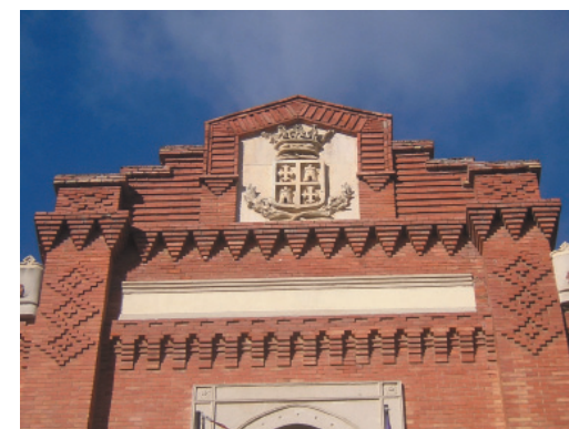
Esudo superior de remate de la fachada.
