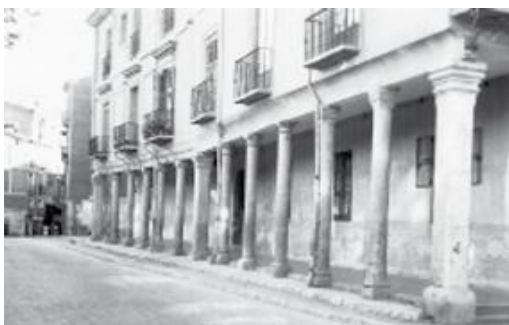
Antiguos soportales de la calle Angustias de Valladolid, hoy desaparecidos.
