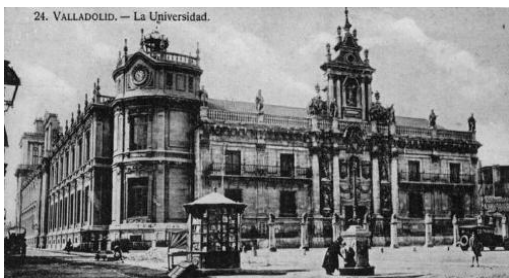
Fachada barroca de la Universidad de Valladolid.
