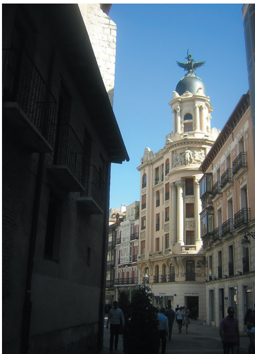
Vista de la calle Santiago de Valladolid en la esquina que forma con la antigua calle de las Cortes Constituyentes, hoy calle de la Constitución, marcada por la silueta del Edificio del Fénix.
