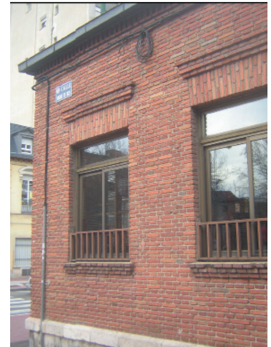
Hueco del pabellón bajo del grupo escolar.
