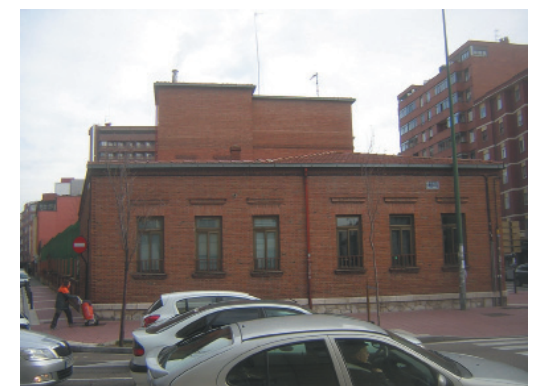
Fachada lateral del pabellón bajo del grupo escolar.
