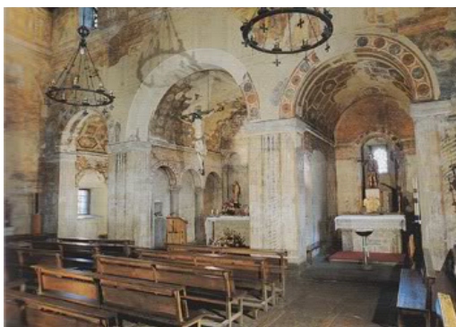
Recuperación de frescos en edificios antiguos para devolverles su carácter originario.
