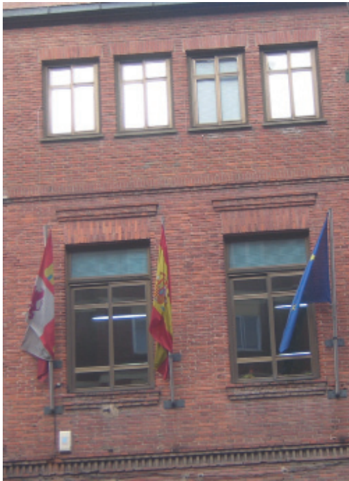
Fachada principal. Huecos de las plantas primera y segunda
