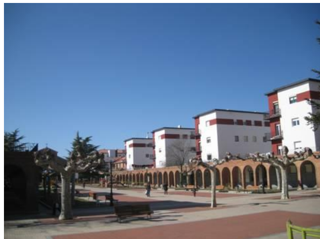
Primera fase, bloques rematados en Terraza.
