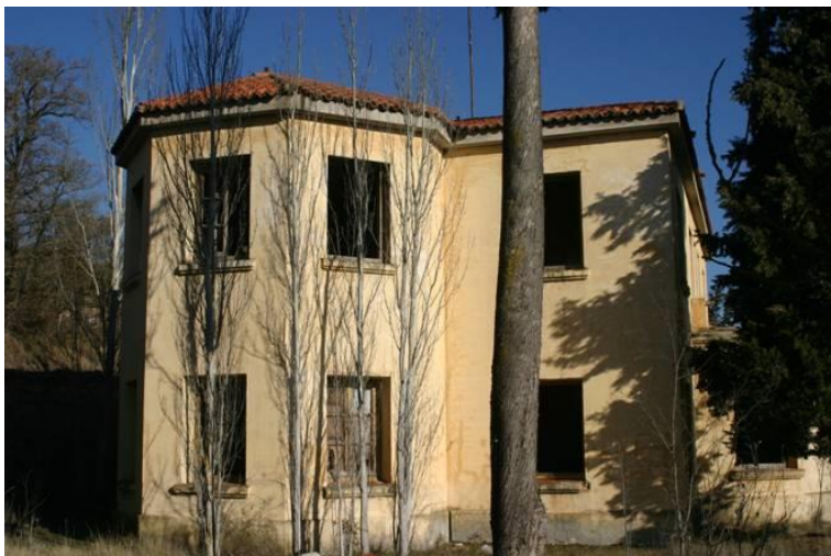
Vivienda Director, estado actual
