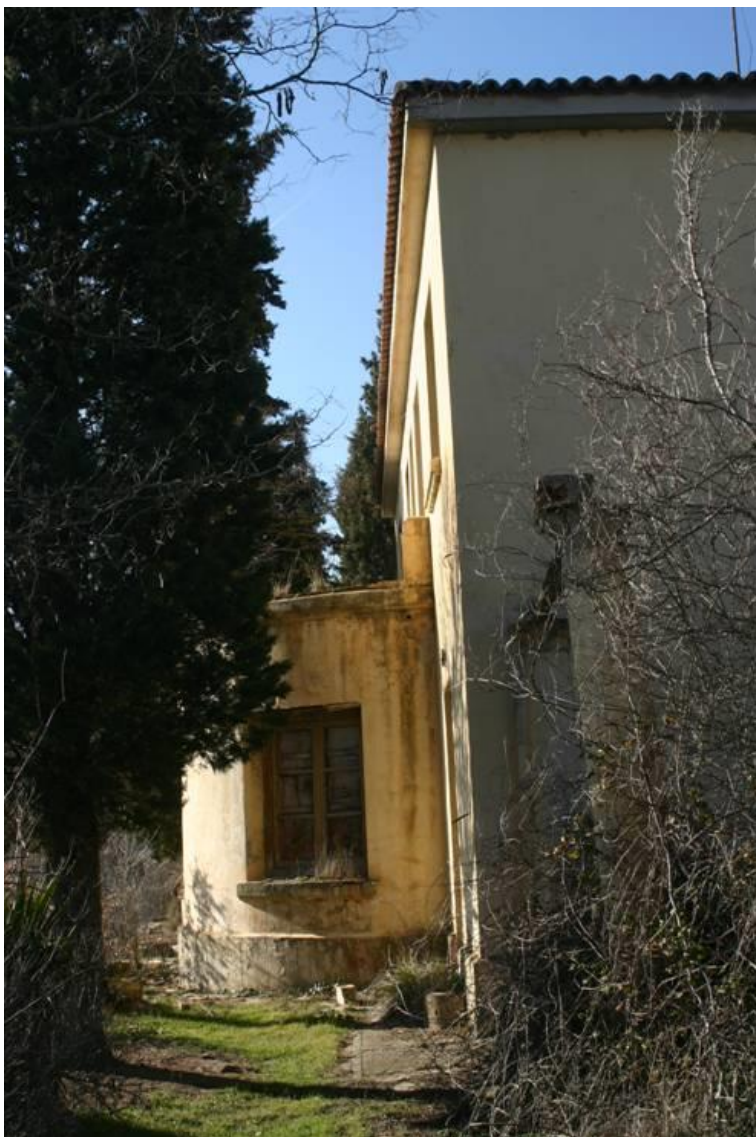
Vivienda del Director, estado actual
