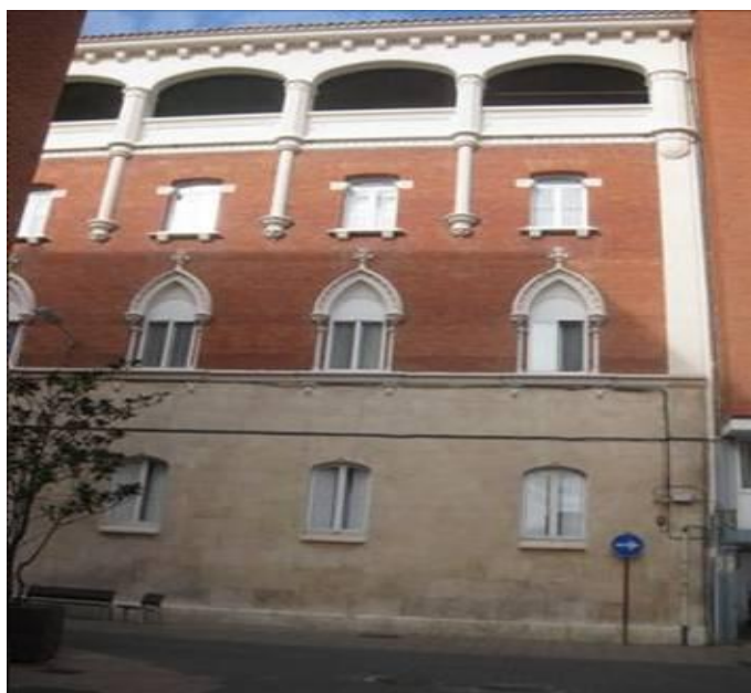
Fachada de la Residencia, con solana superior de 1942.
