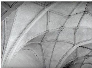
Lesiones en bóvedas
