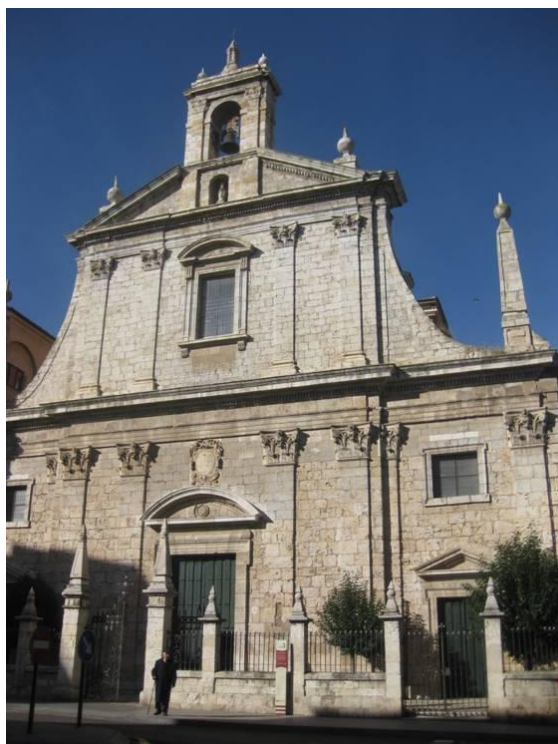
Palencia, Iglesia de La Compañía, fachada restaurada
