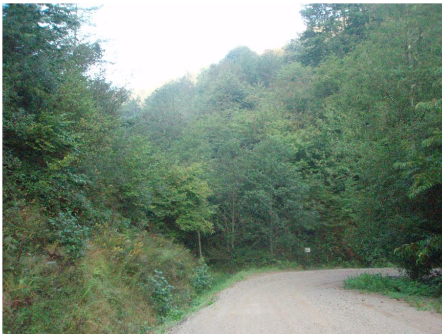
Imagen 16: características de las pistas pertenecientes a la red de pistas de primer orden, con cunetas a los lados, anchuras superiores a 5 metros y firme granular compactado.
