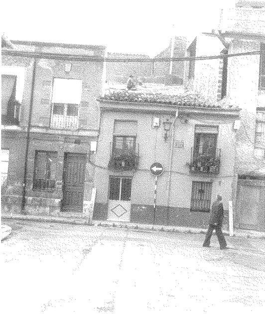
Viejas viviendas de la calle Isidro Polo y primeras obras de remodelado del vetusto caserío del barrio.
