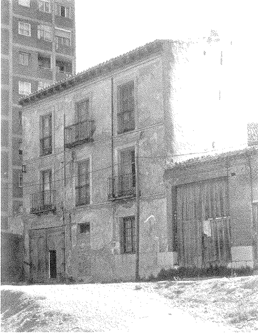
Calle Emperador nº 3 y 5. Viejas y nuevas viviendas de condición modesta en una calle a punto de desaparecer del barrio: la calle Emperador.
