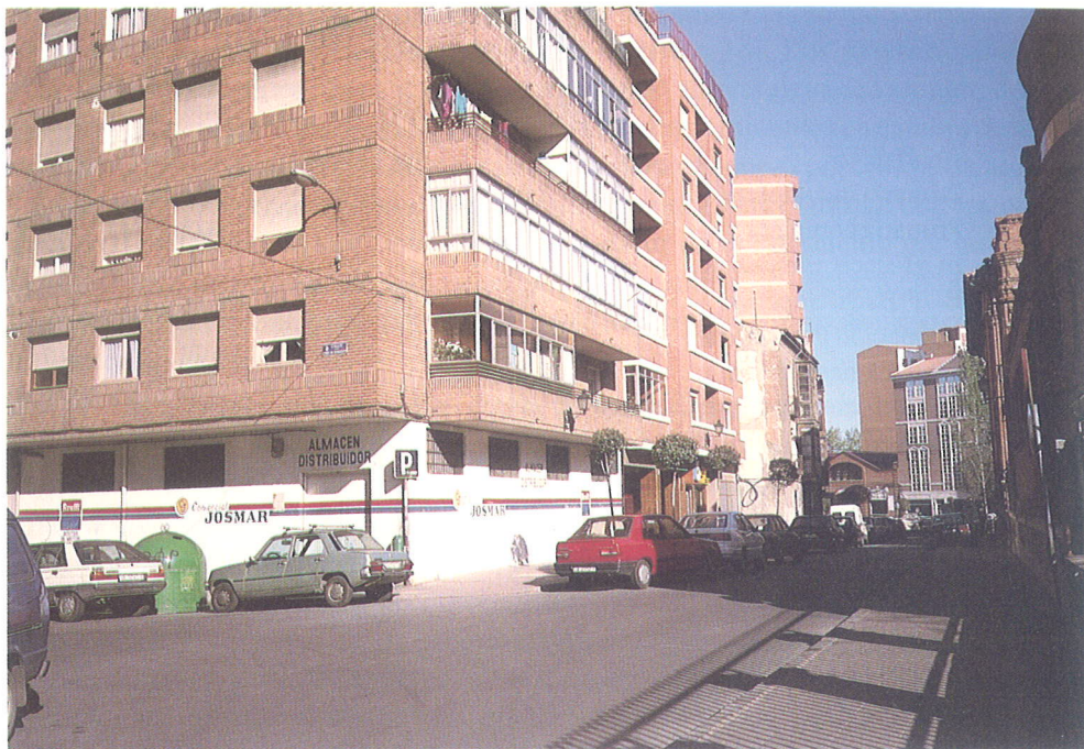
Bajos aprovechados como almacén mayorista en la calle Puente Mayor.
