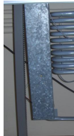
Figura 3.4. Fotografía del generador
