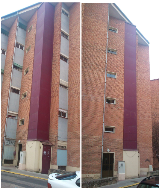
Ascensor instalado en la Comunidad de Pio XII, C/ Larga, Segovia. Foto realizadas el día 26 de marzo de 2016.
