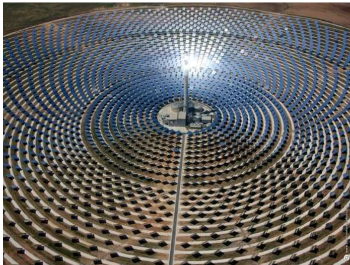
Figura 32: Gemasolar de Torresol
