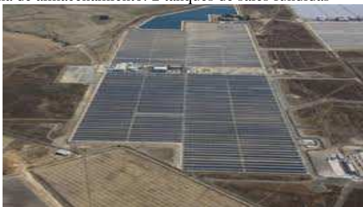
Figura 33: Helioenergy 1 de EON
