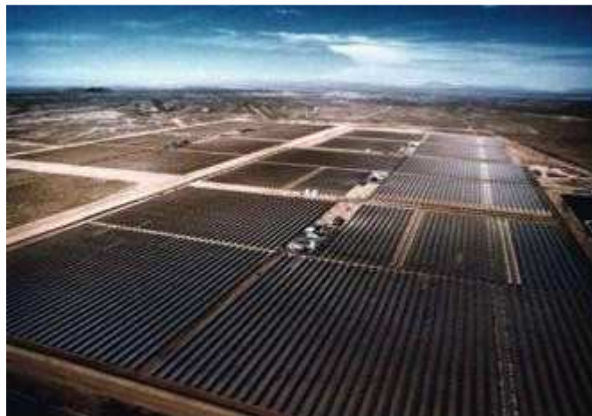
Figura 15: Centrales SEGS, en Mojave, California.
