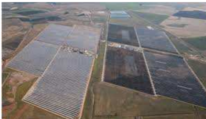
Figura 29: Palma del Río 2 y Palma del Río1 en construcción de Acciona
