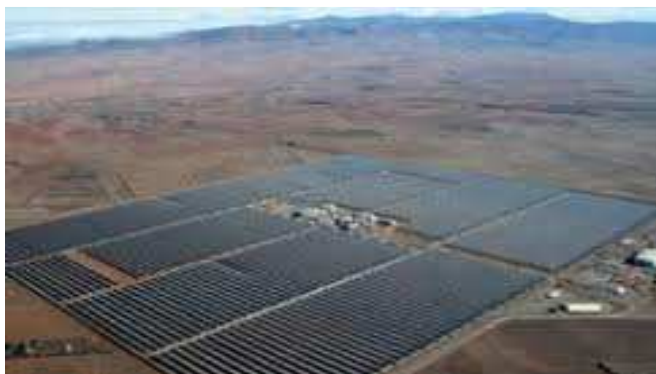
Figura 30: Manchasol 1 y 2 de Cobra
