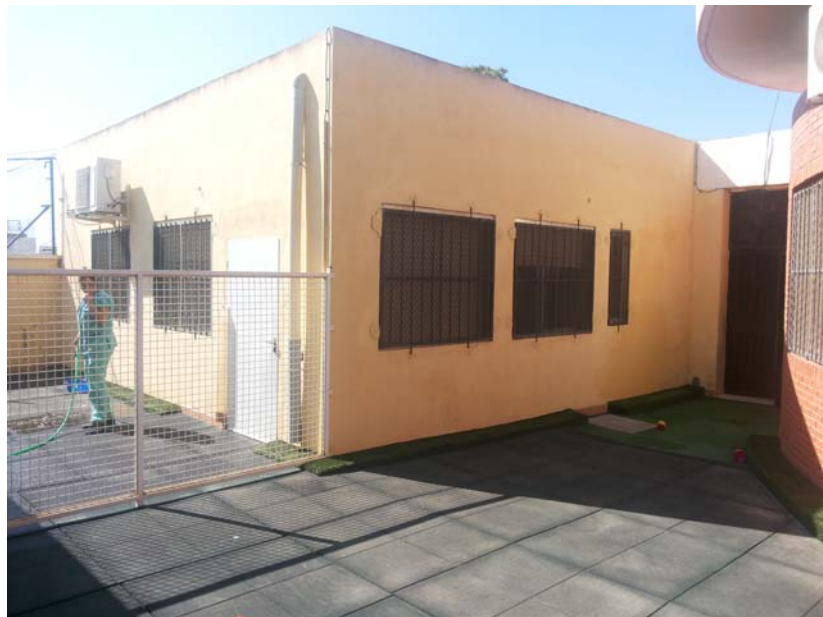
Figura 5.2.5. Fachada trasera II.
