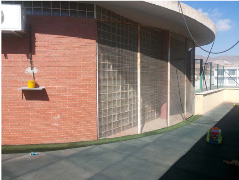
Figura 5.2.4. Fachada trasera I.
