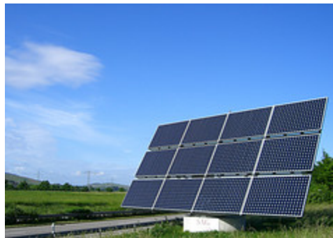
Figura 4: Panel fotovoltaico constituido por módulos.
