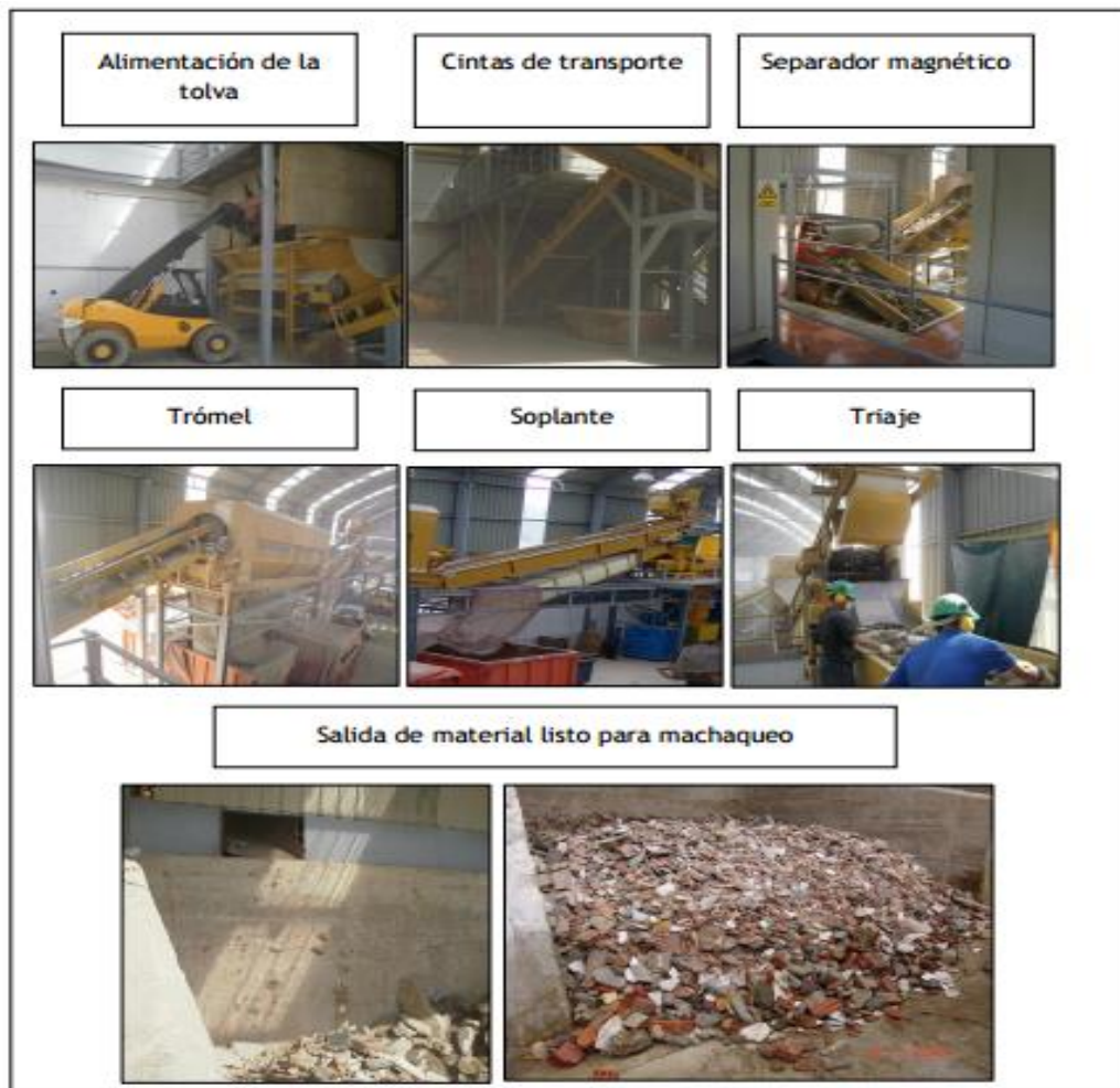
Imagen 5: Proceso de tratamiento en una planta fija.
