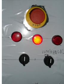
*Imagen 97 Piloto de sobretemperatura en el transformador*
