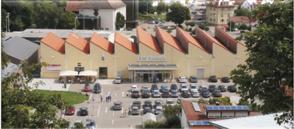
Ilustración 8: Fábrica de metal WMF. (Industriekultur, 2014)
