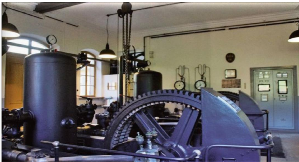
Ilustración 7: Vieja estación de bombeo. (Industriekultur, 2014)
