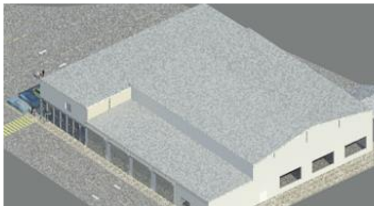
Figura 30: Cubiertas de la nave
