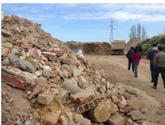
Centro de acopio de residuos de construcción y demolición de la empresa Reciclaje y Medioambiente.
