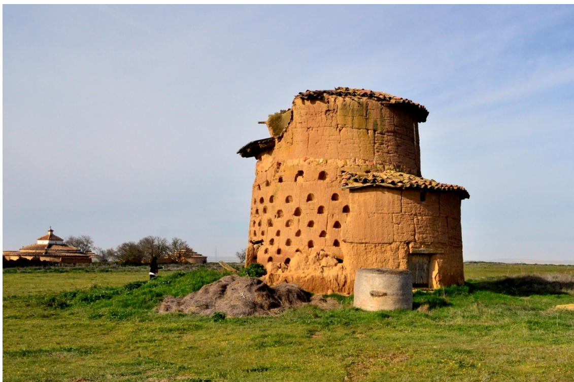
Figura 18. Ruinas de un molino de viento construido en tapial y rehabilitado como palomar. Barcial de la Loma –Valladolid-. D. Herrero, 2013.
