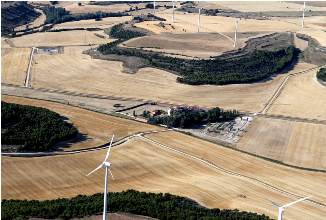
Figura 147. Monasterio Cisterciense de Ntra. Sra. de Alconada –centro- y subestación eléctrica Ampudia 220 kV -superior izquierda-. Ricardo Melgar, 2011.
