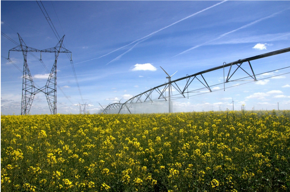
Figura 112. Cultivos de regadío –colza- para su transformación en biocombustible en el municipio de Castromonte, bajo las servidumbres de la línea eléctrica de 220 kV Villacampo-La Mudarra y varios aerogeneradores del parque eólico Peñaflor III. M. Pastor, 2014.
