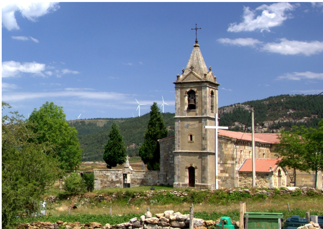
Figura 193. Vista del parque eólico Montejo de Bricia desde la localidad homónima, donde tiene la sede social la Junta Administrativa titular de los terrenos ocupados. D. Herrero, 2012.
