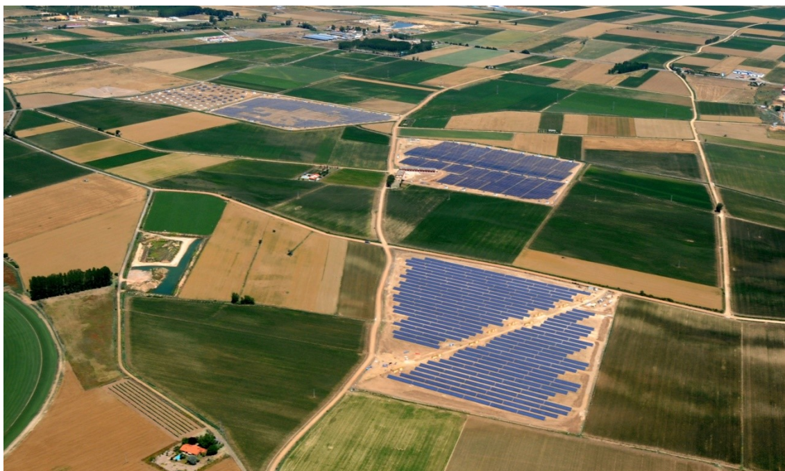
Figura 16. Instalaciones de generación eléctrica a partir de módulos fotovoltaicos sobre el fértil valle del río Duero. E. Baraja, 2008.
