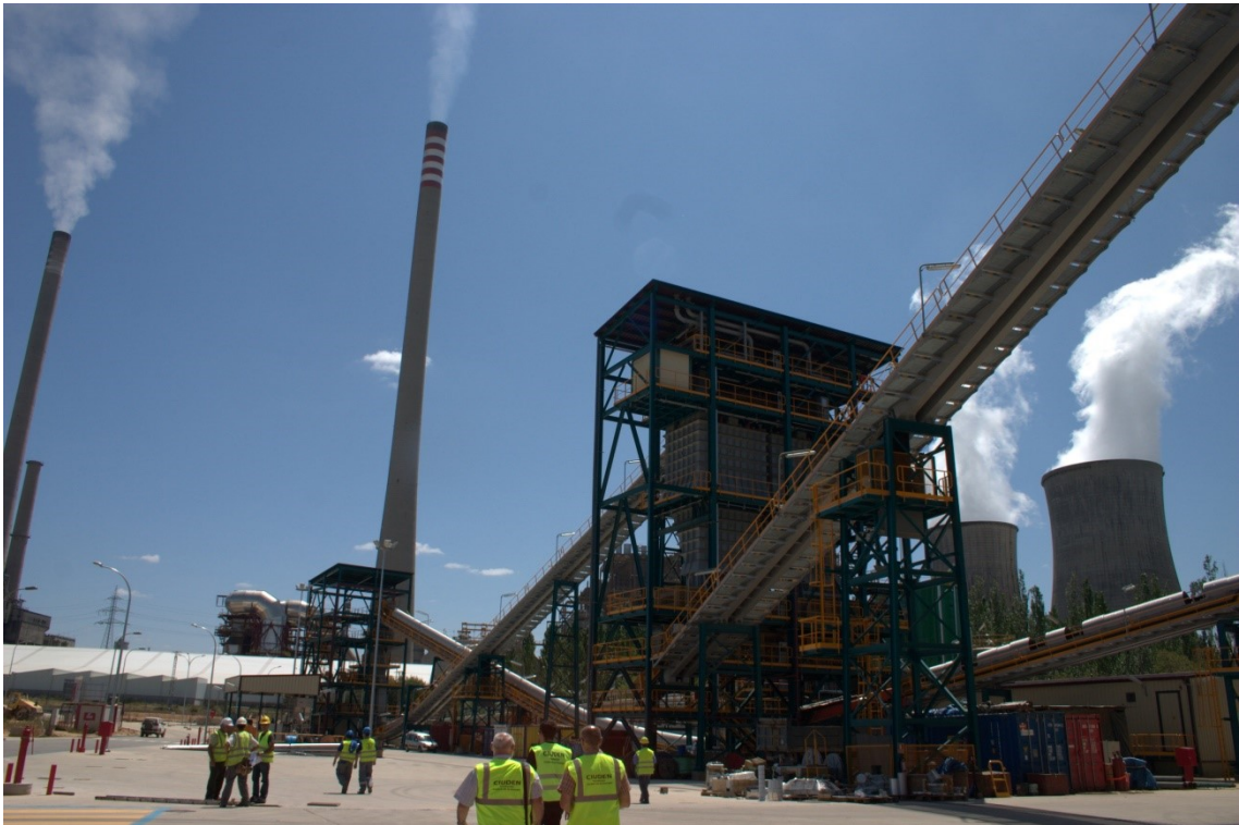
Figura 21. La mayor planta experimental del mundo de captura de CO 2 por el proceso de oxidación, integrada en la Central térmica de Compostilla - Ciudad de la Energía (CIUDEN), Cubillos del Sil, León. D. Herrero 2011.
