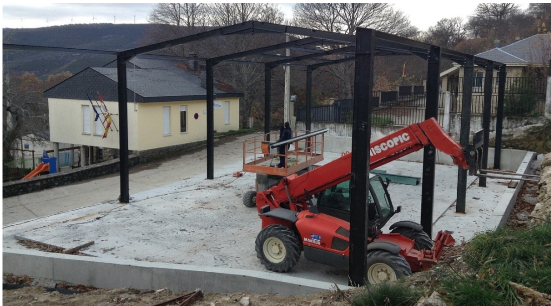
Figura 91. Obras durante la construcción de la pista de pádel en Lubián. D. Herrero, 2014.
