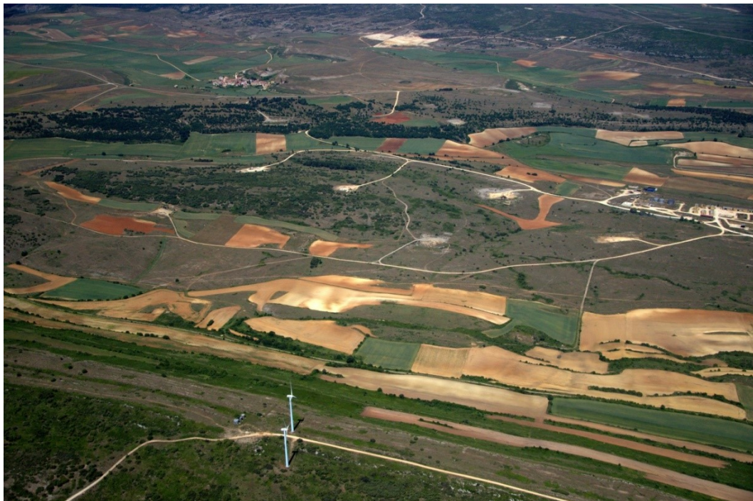
Figura 187. En primer plano dos aerogeneradores del parque eólico Corral Nuevo, y al fondo las plataformas del campo petrolífero de Ayoluengo. D. Herrero, 2015.
