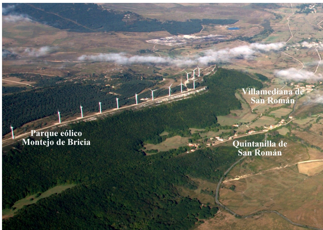
Figura 195. Panorámica general del espacio conflictivo. E. Baraja, 2011.
