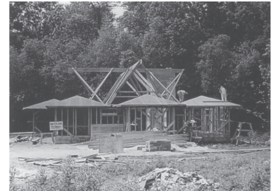
3.395. Louis Kahn, Clever House en construcción, 1962.
