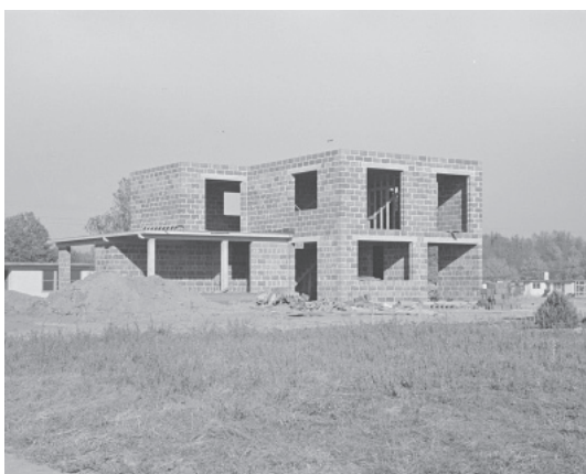
3.52., 3.53 y 3.54. Jersey Homesteads, durante la construcción de las viviendas de una y dos plantas. (L -USF33-011003-M3 C).
