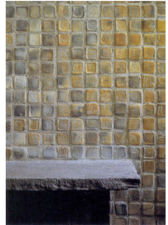
3.263. Fotografía de los azulejos de Mercer de la chimenea de la casa Oser.
