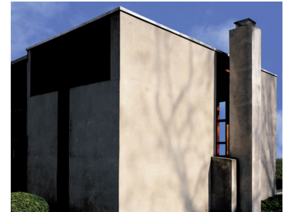
3.618. Louis Kahn, casa Esherick, Chestnut Hill, 1959-61. Vista del alzado lateral de la casa, donde la chimenea se separa del muro y frente a ella se sitúa la ventana.
