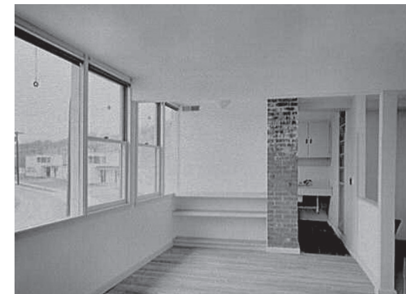
3.103. y 3.104., Howe, Kahn y Stonorov, Carver Court, 1941-44. Exterior e interior de las viviendas. (LC -G612-T01-44535, LC-G612-T-44522)
