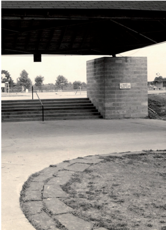
3.401. Louis Kahn, Baños de Trenton, Apoyo de la cubierta.
