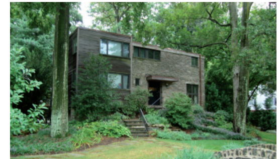
3.256 y 3.257. Louis Kahn, terraza posterior de la casa Oser, en la que se encuentran la chimenea de piedra y la pieza superior de madera. Vista desde el acceso, fachada principal.
