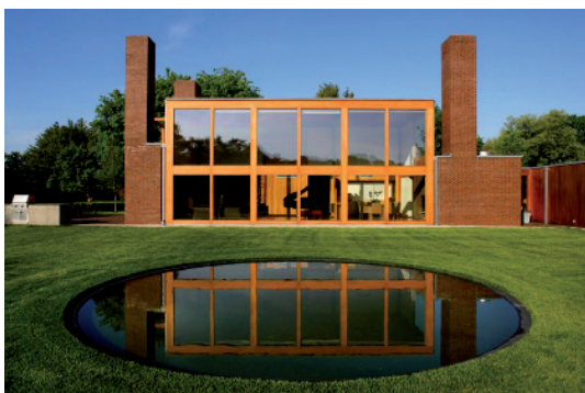
3.650. Louis Kahn, casa Korman, Fort Washington, 1973, (AAPU, LIKC, 845). Imágenes de las chimeneas.
