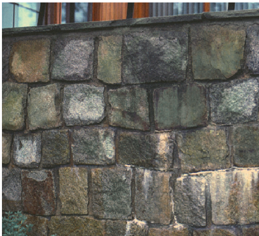
3.332. y 3.333. Louis Kahn, Weiss House y Genel House, basamento de piedra.
