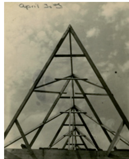
3.400. Anne Tyng, Walworth Tyng House, estructura de cubierta durante su construcción.
