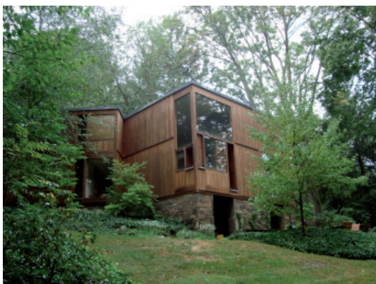
1.16. Louis Kahn, Fisher House, Hatboro, 1960-67 Vista desde la parte posterior de la parcela en la que se aprecia el basamento de piedra y sobre el la cabaña de madera.
