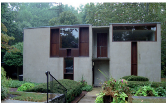
3.345. Louis Kahn, Esherick House, 1959-61, vista exterior de la casa.
