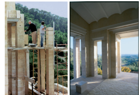
3.533. Jorn Utzon, Can de Lis, durante la construcción, 1971-73.
