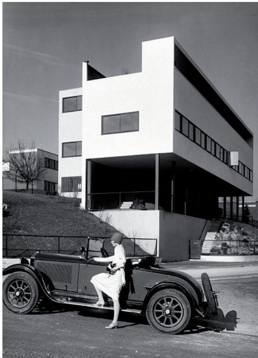
3.98. y 3.99. Le Corbusier, "Cinco puntos de una nueva arquitectura", 1926. Colonia Weissenhof, Stuttgart, Alemania, 1926-27.
