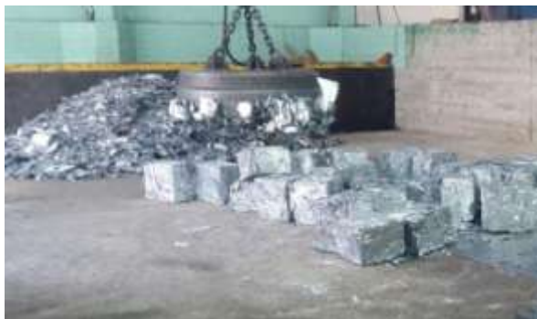
Imagen 15. Puente grúa con equipo de elevación electromagnética
