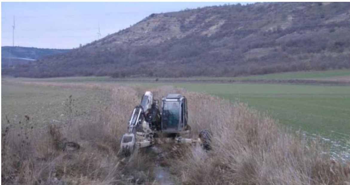
Figura 30. Actuación mediante retroaraña en Villaviudas, Palencia. Tomada de Fundación Biodiversidad (2005).
