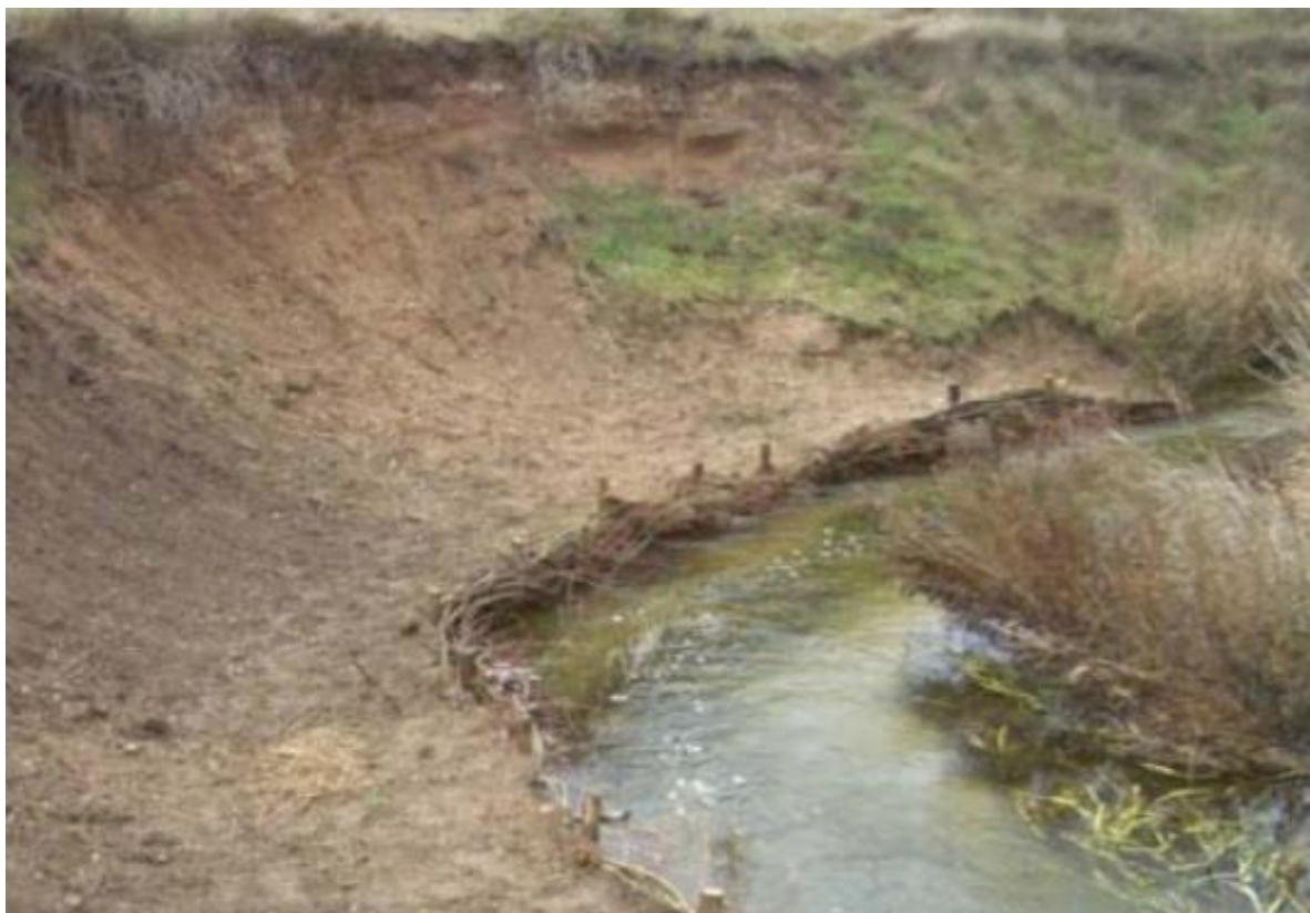
Figura 28. Actuación en Villaviudas, Palencia. Construcción de empalizadas trenzadas. Tomada de Fundación Biodiversidad (2005).
