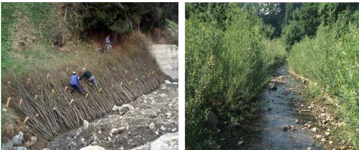
Figura 29. Ejemplo de actuación mediante esteras de ramaje. Colocación de las esteras (izquierda) y resultados en verano (derecha). Tomada de Florinech, M.
