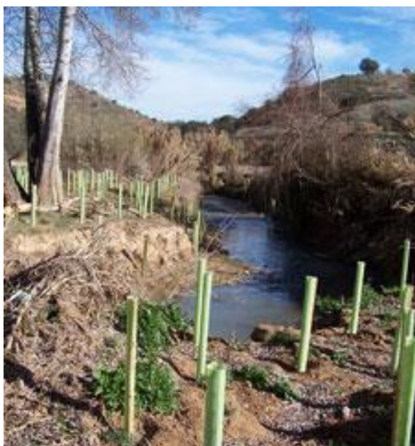
Figura 25. Revegetación de márgenes en el canal de Bembézar, Córdoba. Tomada de Deifontes, M.
