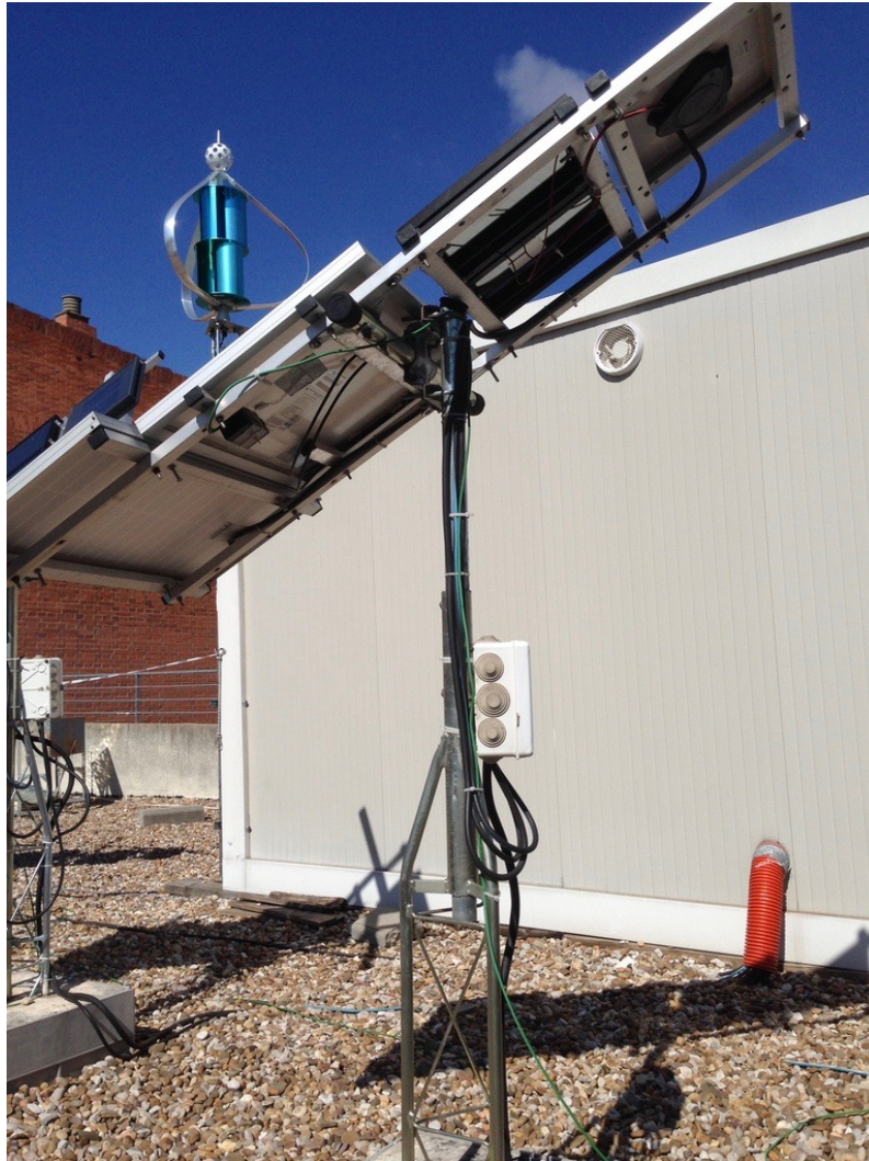
ESTRUCTURA BASE DE LOS PANELES
