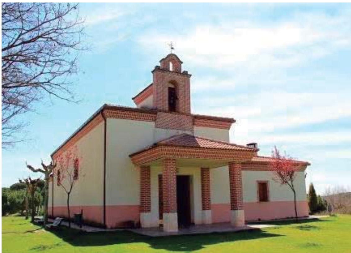
Ilustración 117: exterior de la ermita de Pedrajas de San Esteban (fuente: www.panoramio.com )
