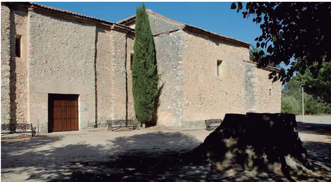
Ilustración 98: exterior de la ermita de Mojados (fuente: www. provinciadevalladolid.com )
