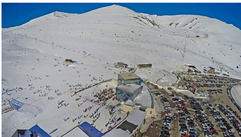
Figura 6: Estación invernal Alto Campo (Fuente: El Diario Montañes)
