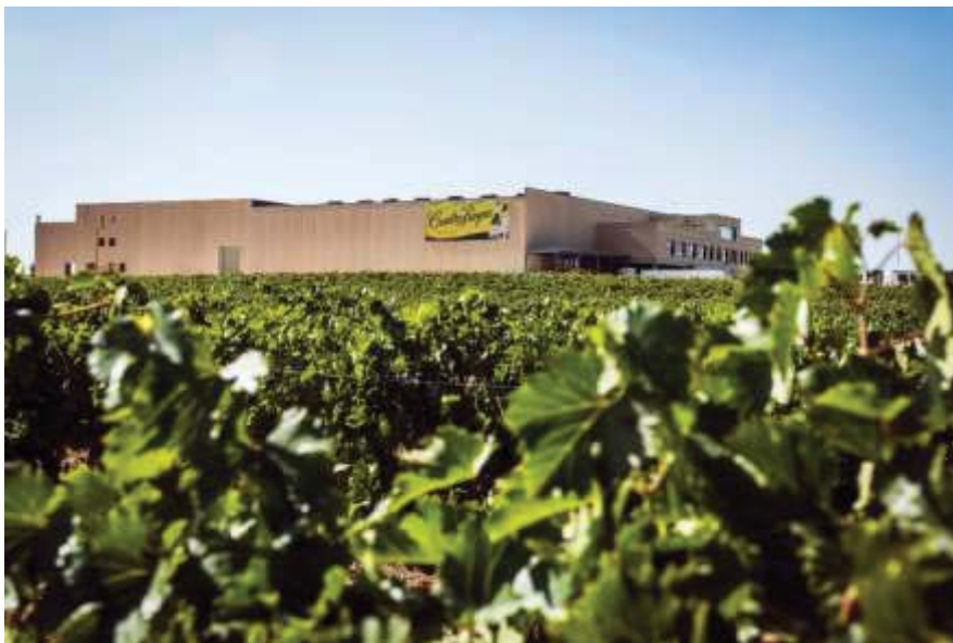
Figura 8: Exterior de las nuevas instalaciones de Cuatro Rayas
